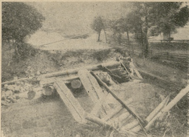
Ryc. 3. Zerwany most na potoku Czerna. Fot. S. Sowiński
