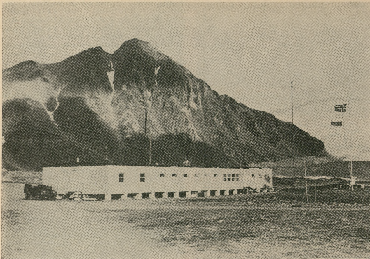
Ryc. 6. Polska stacja naukowa na Spitsbergenie. Fot. J. Pruchnicki
