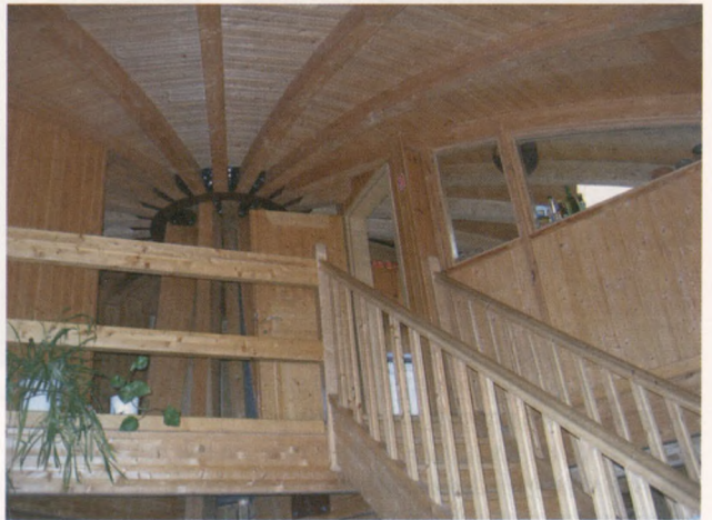
Ryc. 2. Wejście na piętro Domespace. Fot. K. Mazurski
