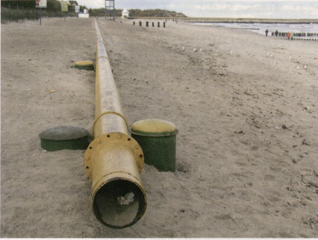
Ryc. 9 c. Formy zabezpieczenia brzegu morskiego — rura refulacyjna. Fot. U. Żurek-Pysz
