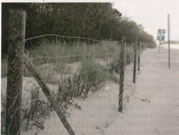
Ryc. 9 b. Formy zabezpieczenia brzegu morskiego — zabudowa biologiczna. Fot. U. Żurek-Pysz
