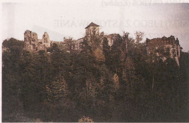
Ryc. 4. Ruiny zamku Tęczyn w Rudnie na wzgórzu zbudowanym z melafirów. Fot. E. Szwed
