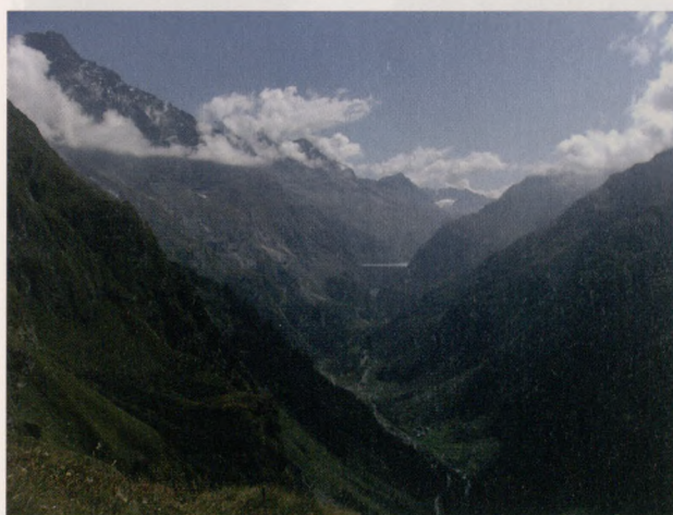
Ryc. 4. Dolina Bagnes z widoczną w głębi 250-metrowej wysokości zaporą de Mauvosin. Fot. A. Sobczyk
