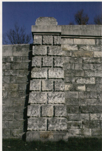
Ryc. 6. Mur przeciwpowodziowy z dolomitu diploporowego na lewym brzegu Wisły poniżej Skałki. Fot. J. Rajchel
