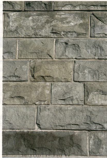
Ryc. 2. Mur oporowy z piaskowca godulskiego u podnóża Wawelu. Fot. J. Rajchel
