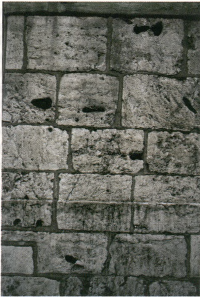
Ryc. 1. Fragment ściany z bloków górnourajskiego wapienia o charakterze grand appareil . Fot. J. Rajchel
