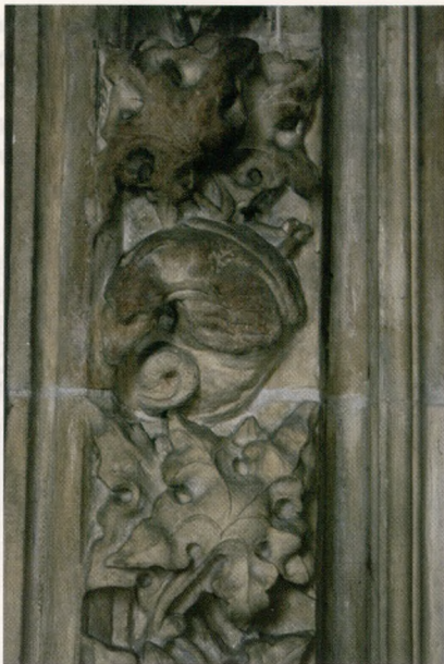
Ryc. 4. Fragment rzeźbionego w liście przestępu portalu z wapienia pińczowskiego w kościele oo. Dominikanów. Fot. J. Rajchel
