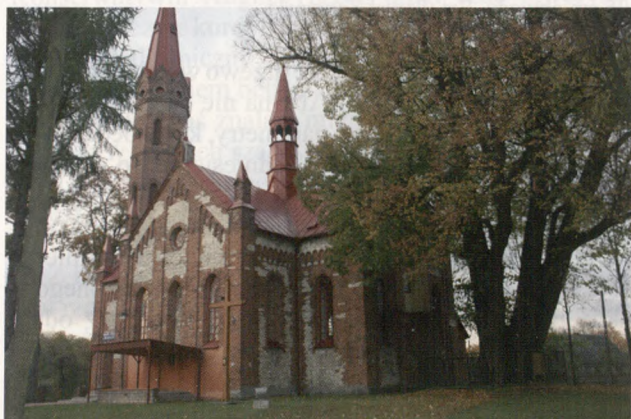
Ryc. 3. Lipa z Cielętnik rośnie tuż przy murze miejscowego kościoła, wybudowanego w 1891 r. Fot. Paweł Zarzyński
