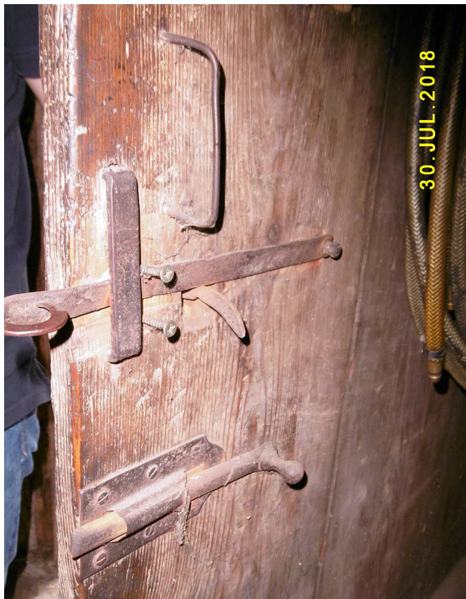
Fot. nr 64. Zapadka od wewnątrz drzwi, którą uruchamia naciśnięcie palcem bębena po przeciwnej ich stronie.
