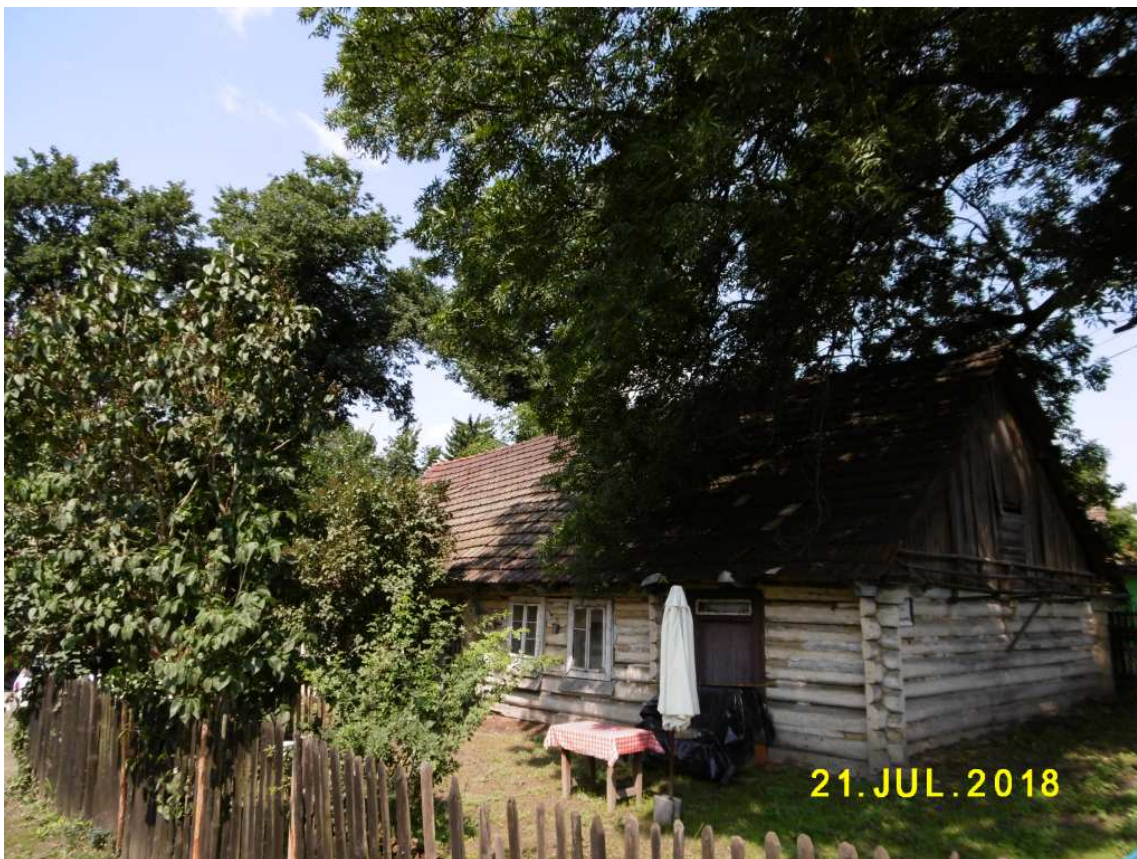
Fot. nr 106 (106-108). Ujęcia od strony ogrodu.
