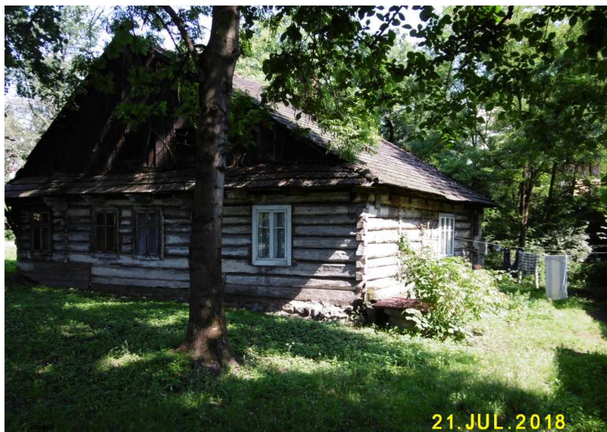
Fot. nr 91. Fragment od strony podwórka.
