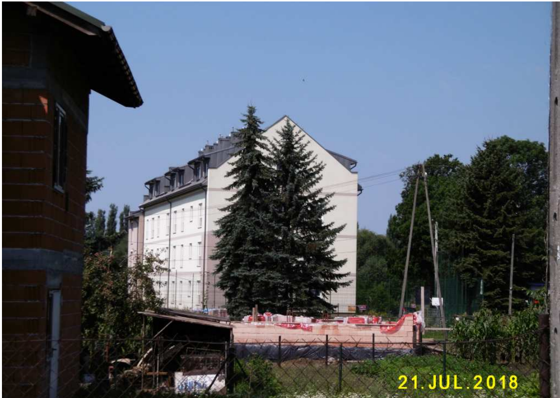
Fot. nr 130 (130-131). Źałosny widok na współczesną przeróbkę dawnego młyna „gwoździarnia” z ulicy Bardosa 38, pochodzącego z I ćwierci XX wieku. Gdy młyn przestał działać funkcjonowała tu fabryka gwoździ. Sam blok mieszkalny stoi pusty od kilku lat.
