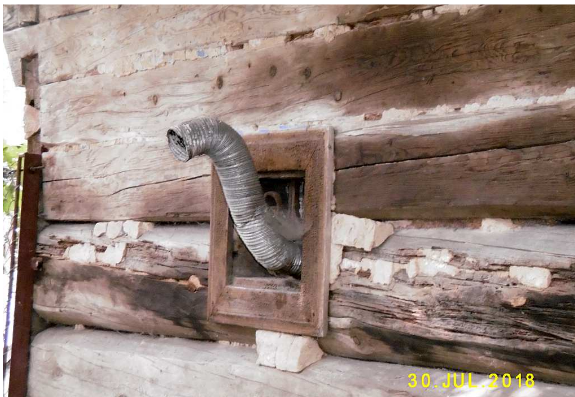
Fot. nr 77. Wspomnienie po dawnym warsztacie mechanicznym.
