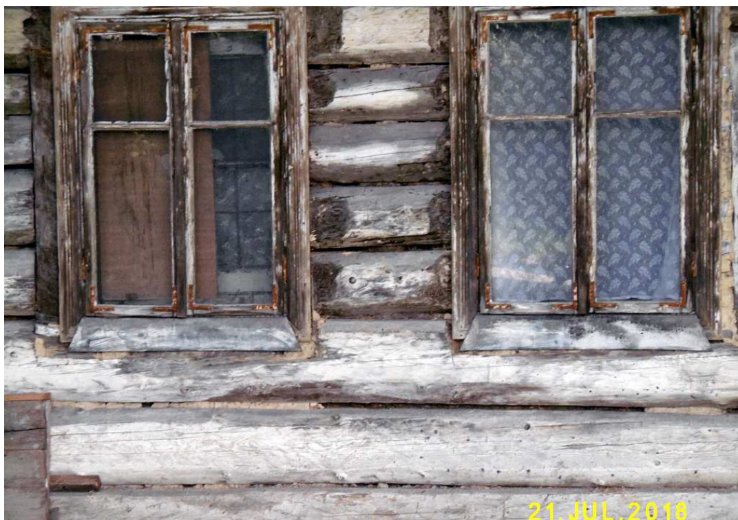
Fot. nr 90. Oryginalne okna.
