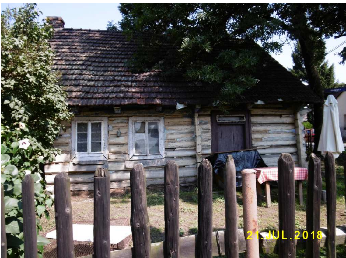
Fot. nr 107. Część mieszkalna.
