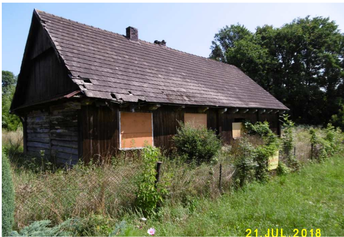
Fot. nr 133. Ujęcie z ulicy Powiatowej.
