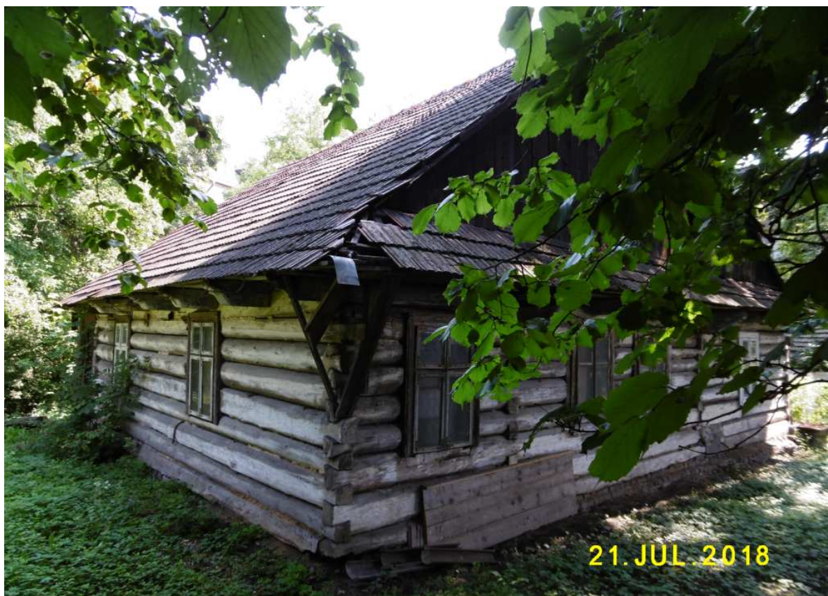
Fot. nr 88 (88-91). Ujęcia narożnika.
