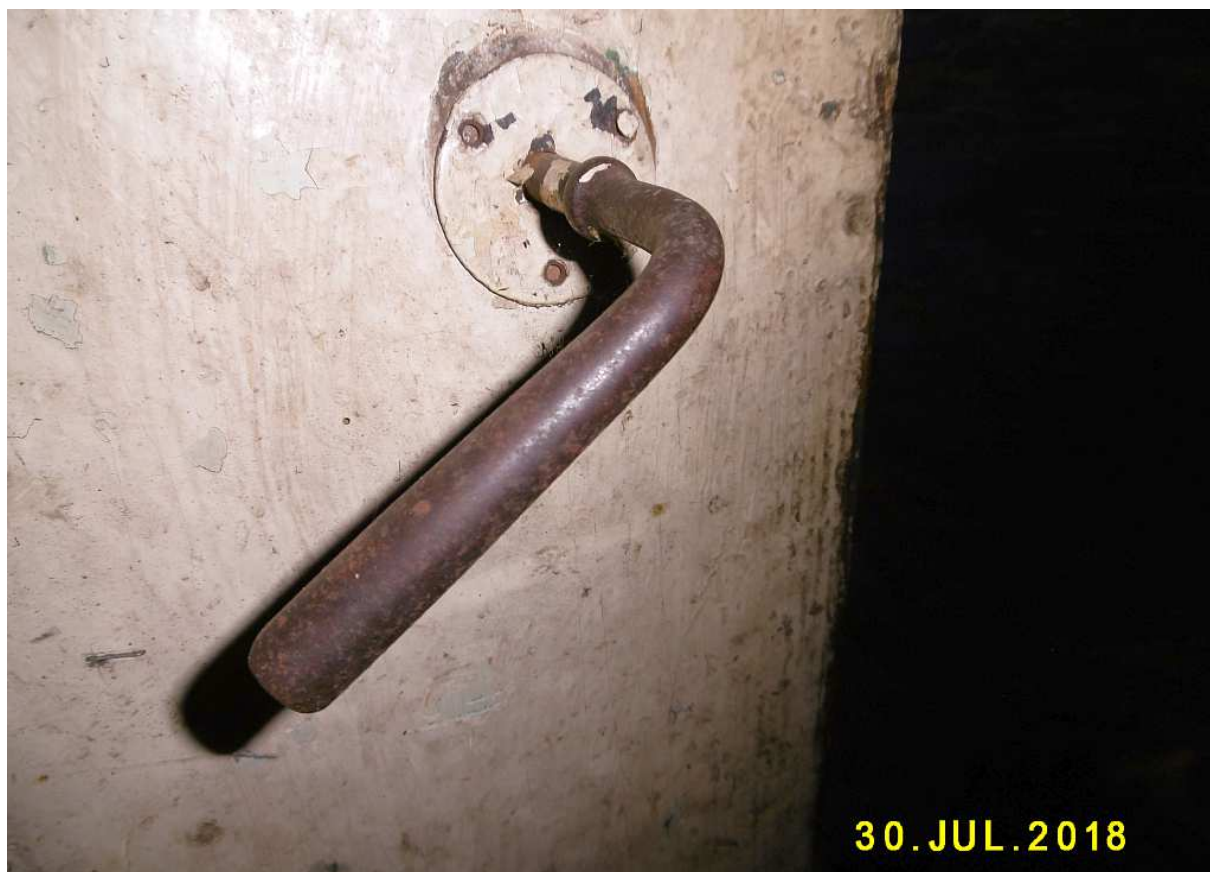
Fot. nr 70 (70-73). Detale kolejnych drzwi wewnętrznych. Tu archaiczna klamka.
