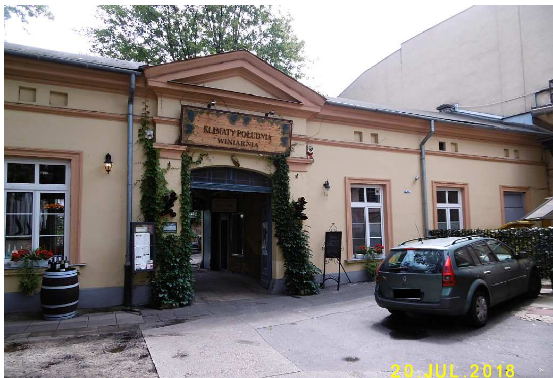
Fot. nr 11 (11-14). Parterowy budynek o cechach klasycystycznych w głębi posesji przy ulicy św. Gertrudy 5a, gdzie dziś mieści się winiarnia Klimaty Południa.
