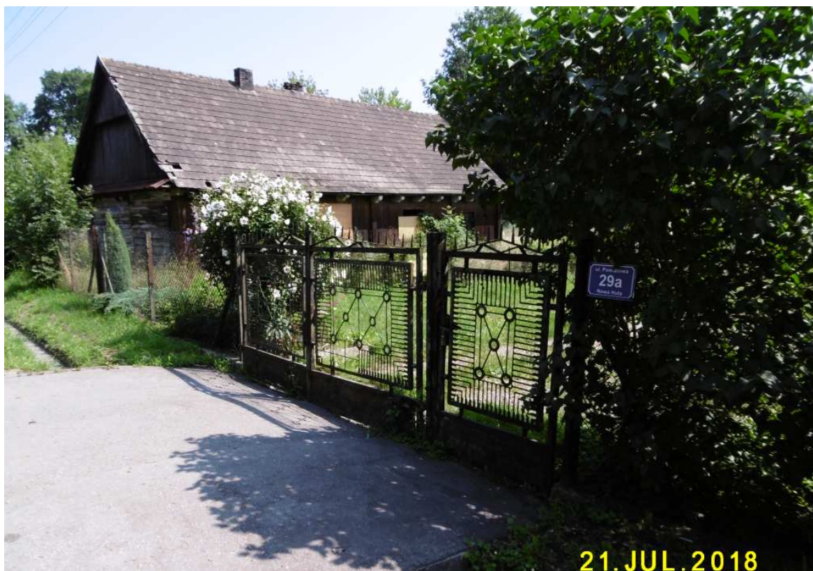
Fot. nr 132 (132-137). Ruina wiekowej chałupy z ulicy Powiatowej 29, która powstała na przełomie XIX i XX wieku.
