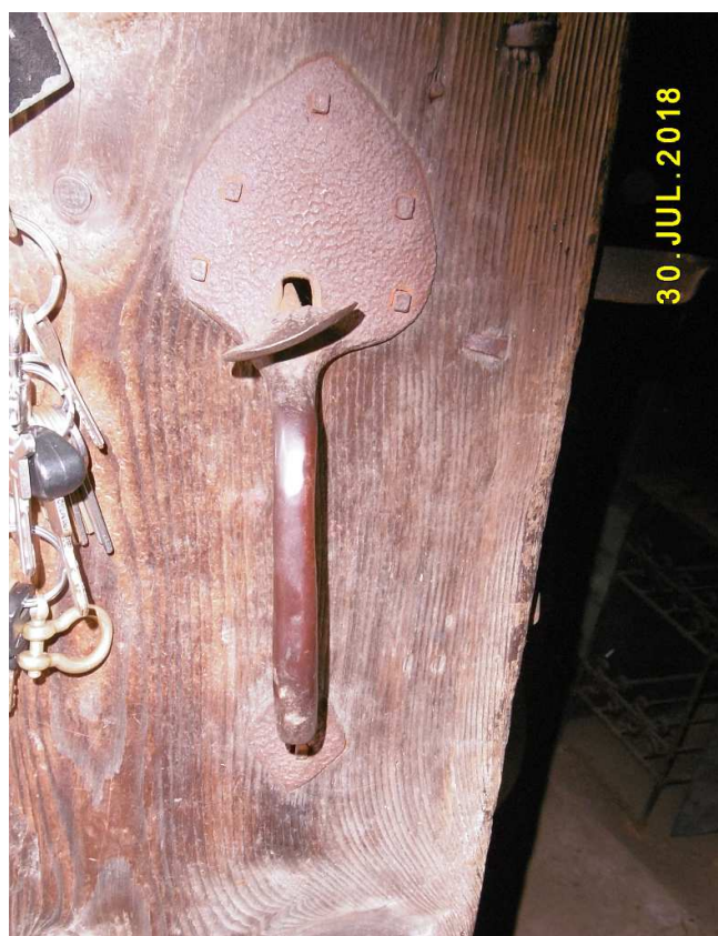
Fot. nr 63 (63-64). Archaiczny mechanizm zapadkowy do zamykanie drzwi.
