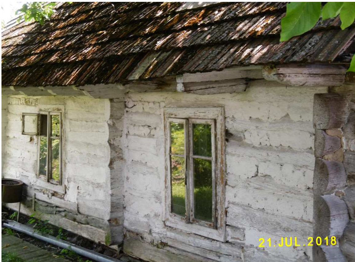
Fot. nr 102 (102-103). Oryginalne okna.
