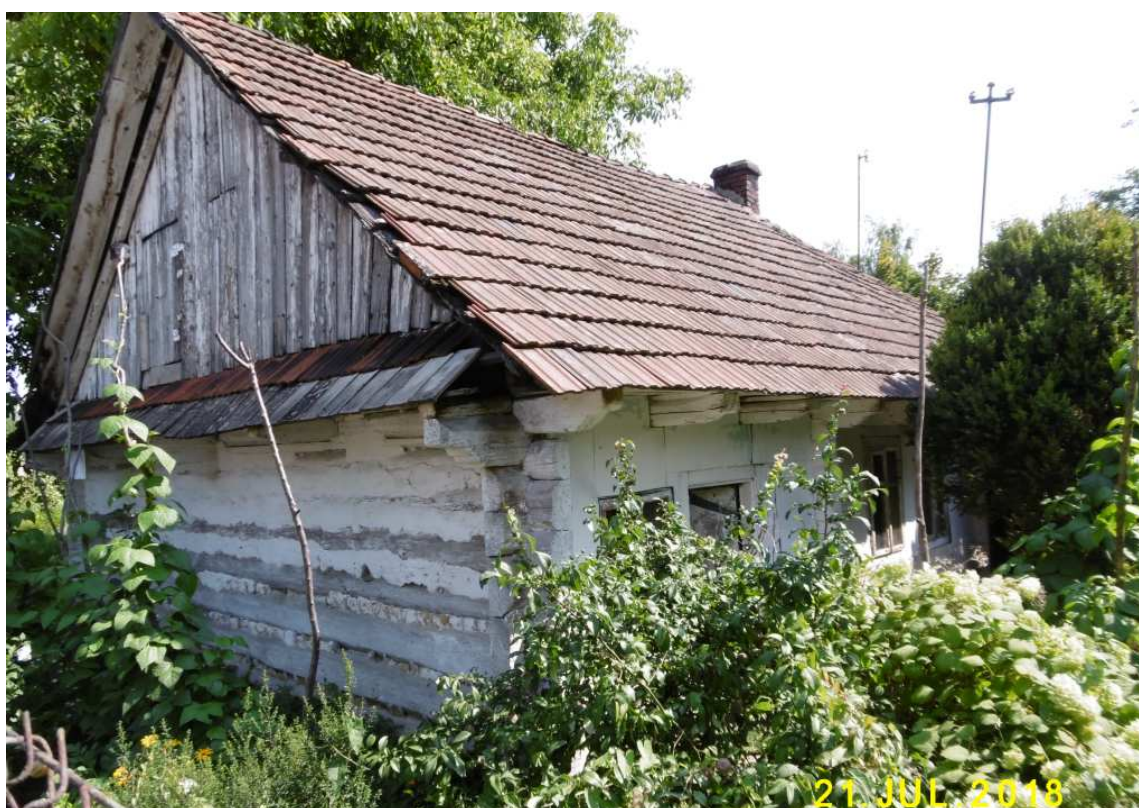
Fot. nr 95 (95-103). Chałupa z ulicy Stare Wiślisko 67, która wg Antoniego Łapajerskiego, dokumentalisty Nowej Huty, powstała w roku 1898. Fot. nr: 95-98 – widoki od strony ogrodu.
