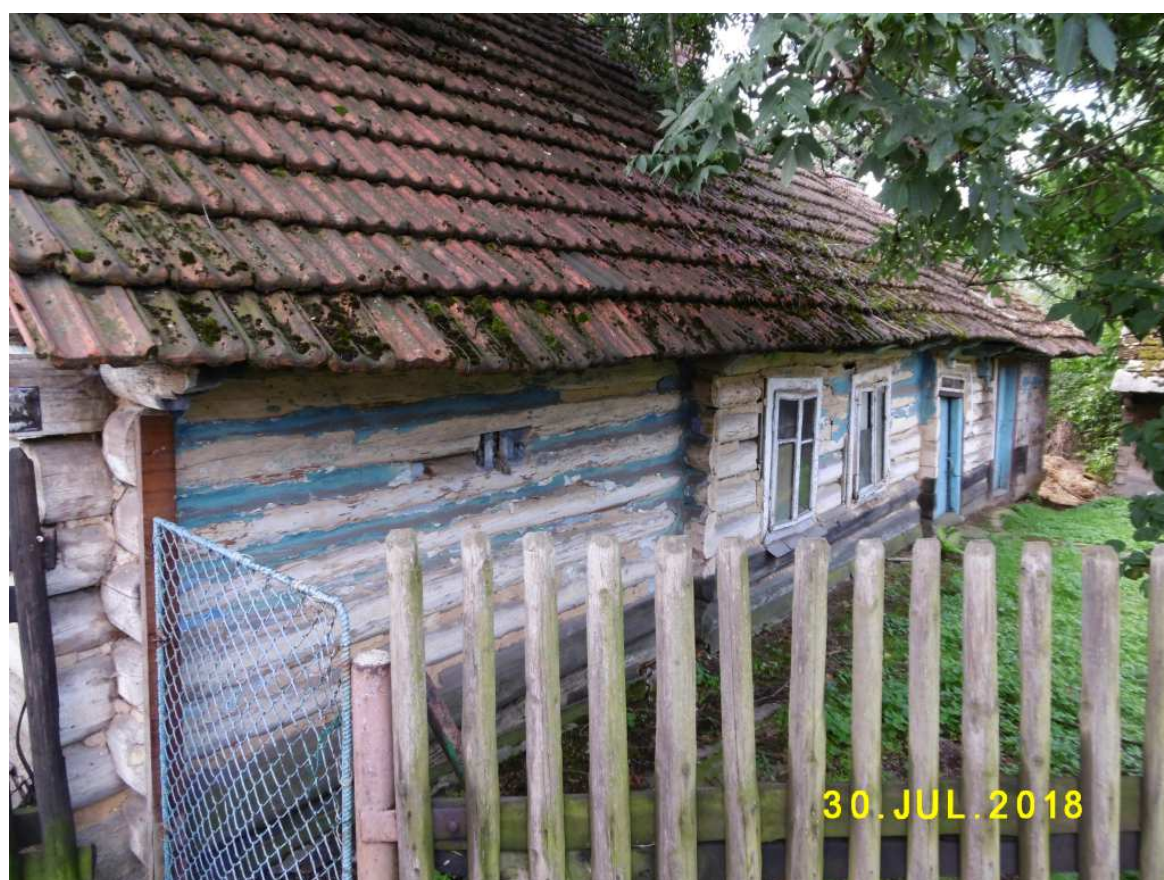
Fot. nr 119 (119-122). Fragment chałupy od strony dawnego podwórka i jej detale.
