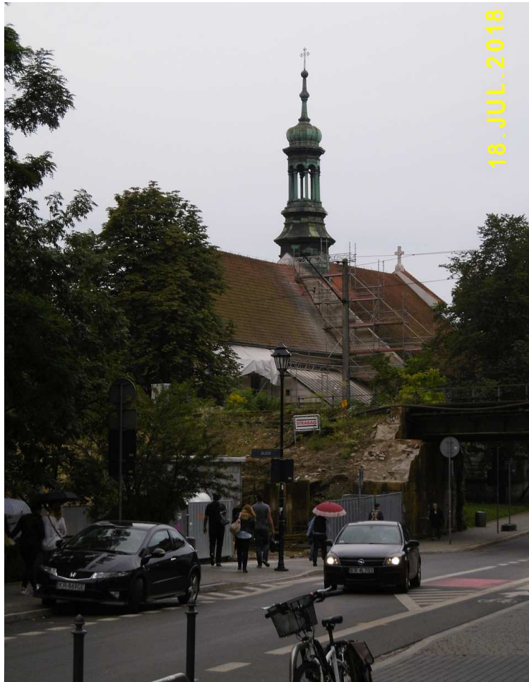
Fot. nr 36. Ponad przebudowywanym nasypem kolejowym w stronę kościoła św. Mikołaja.
