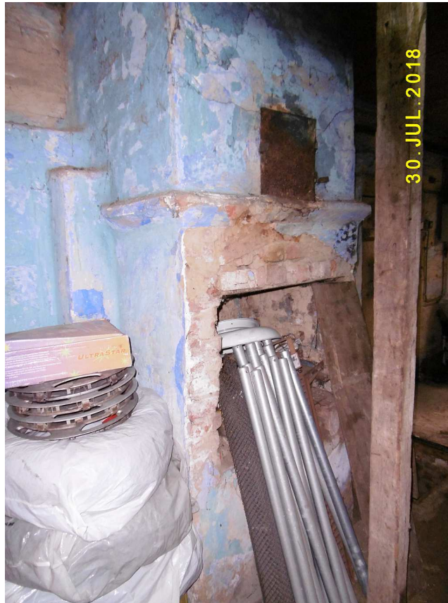
Fot. nr 74. Piec do wypieku chleba zlokalizowany w sieni przelotowej.
