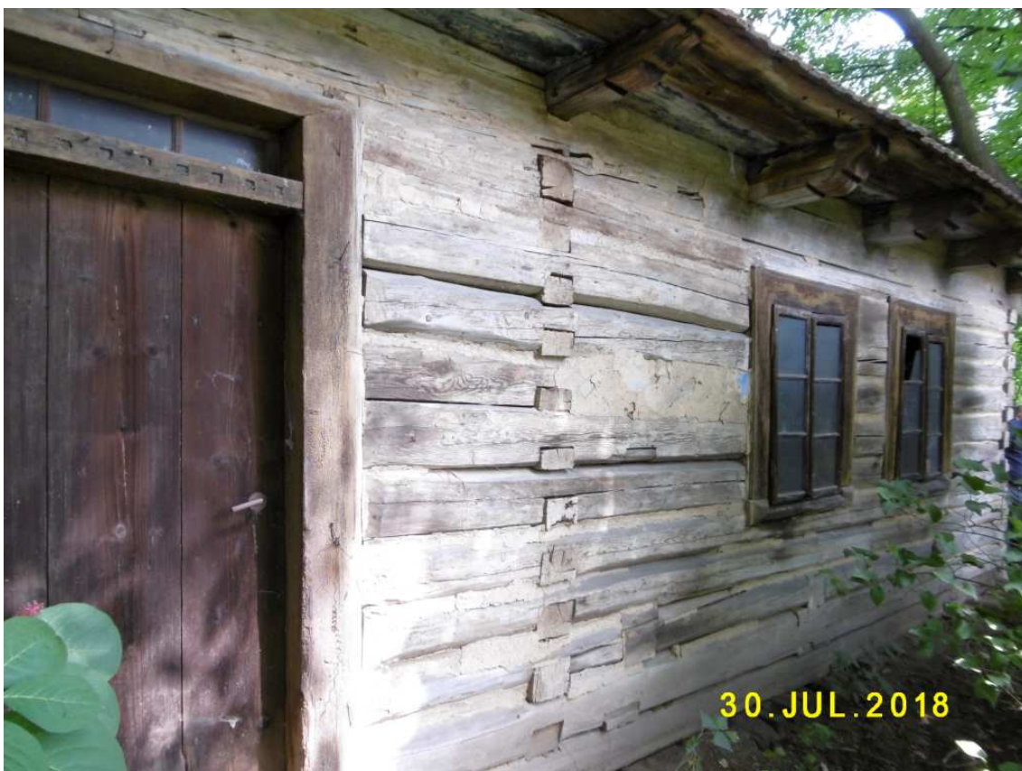
Fot. nr 78 (77-78). Oryginalne okna i faktura ściany.
