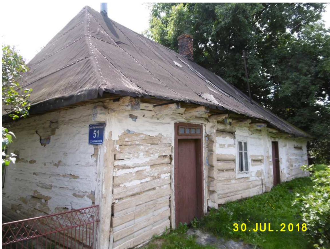
Fot. nr 82 (82-83). Fragment od strony dawnego podwórka.
