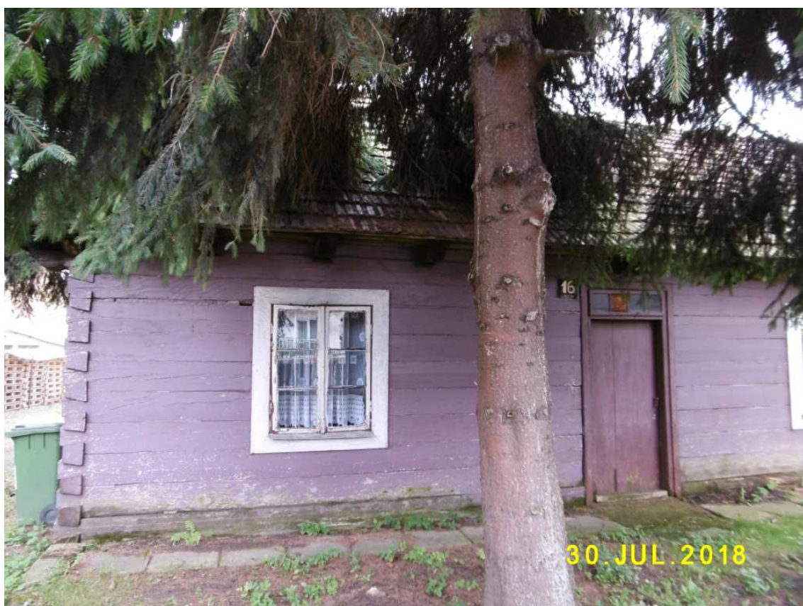
Fot. nr 36. Oryginalne okno i także drzwi ze świetlikiem z mozaikowymi kiedyś szybkami.
