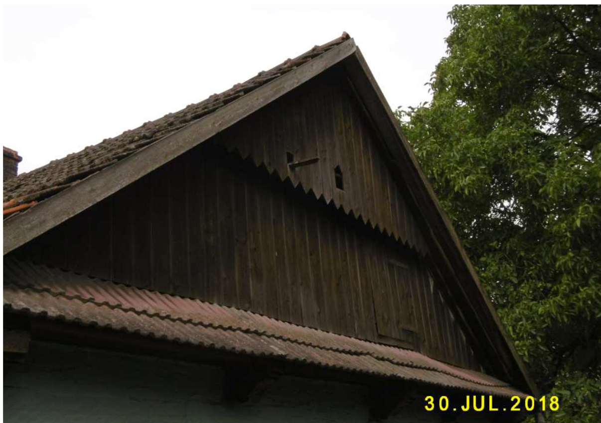
Fot. nr 26. Szczytowa konstrukcja dachu w prawej bocznej ścianie.
