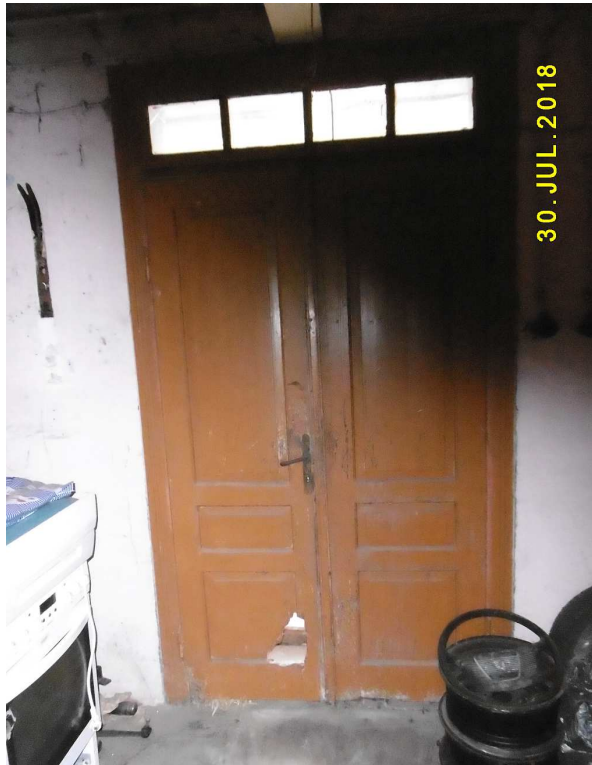
Fot. nr 9. Drzwi ze świetlikiem, wiodące na ganek z wnętrza domu.
