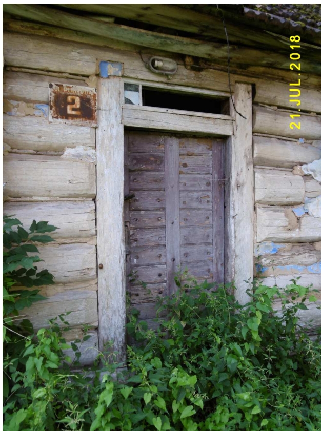
Fot. nr 76. Archaiczne drzwi z tabliczką.
