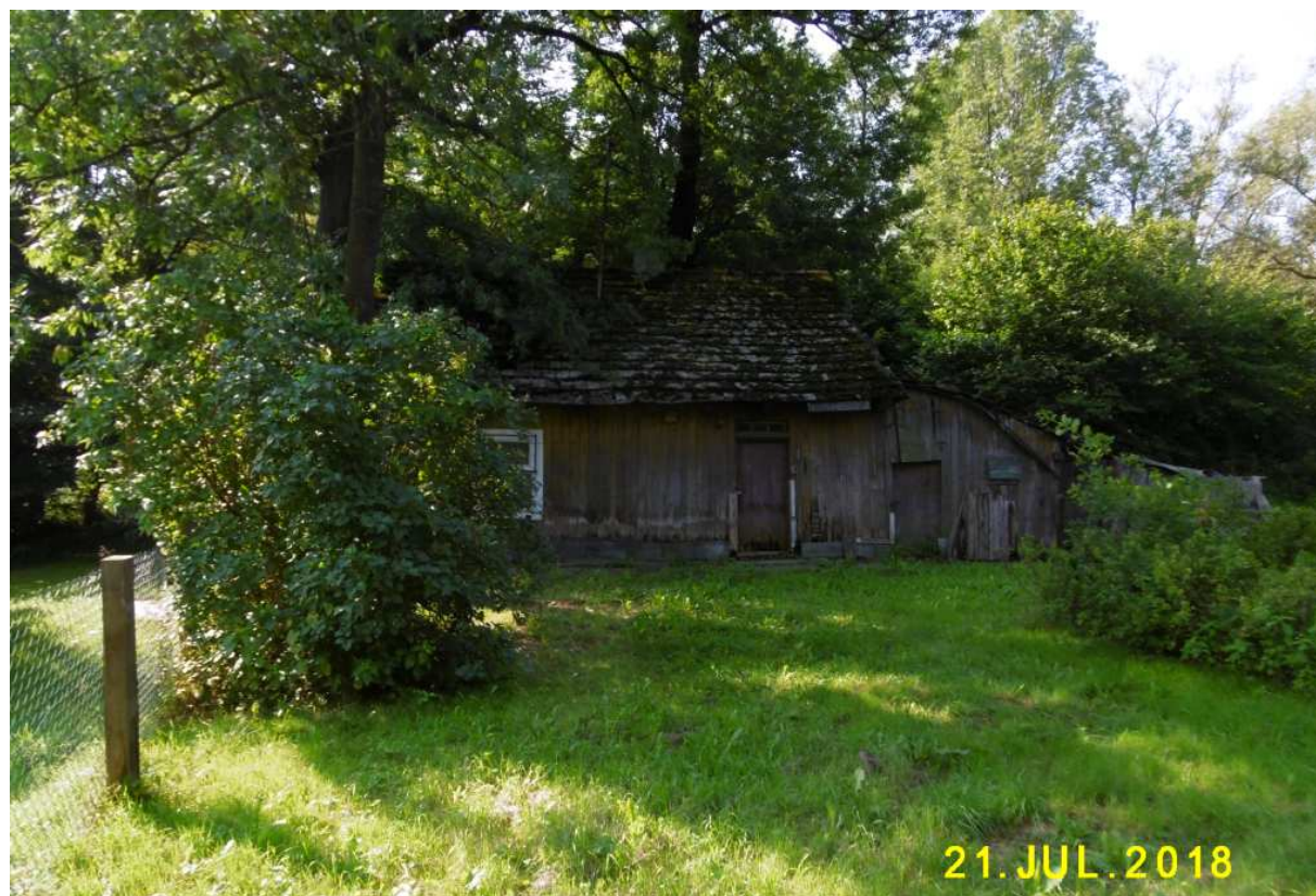
Fot. nr 125. Drewniany dom w głębi posesji przy ulicy Wrobela 77.
