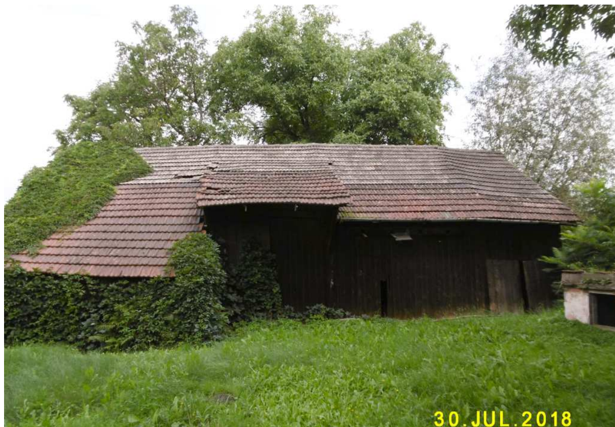
Fot. nr 31 (31-32). Bliska oryginałowi stodoła w końcowym fragmencie dziedzińca.
