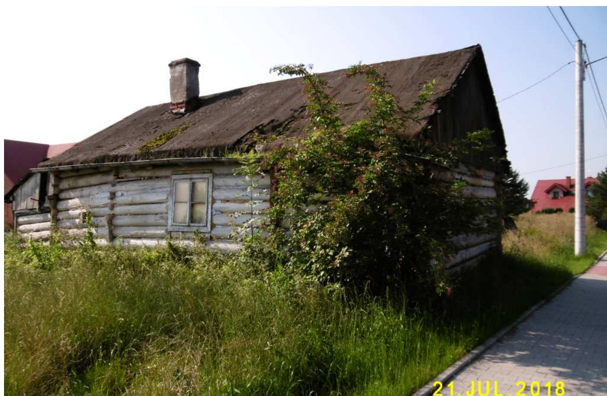
Fot. nr 119 (119-124). Fragment chałupy od strony dawnego ogrodu.
