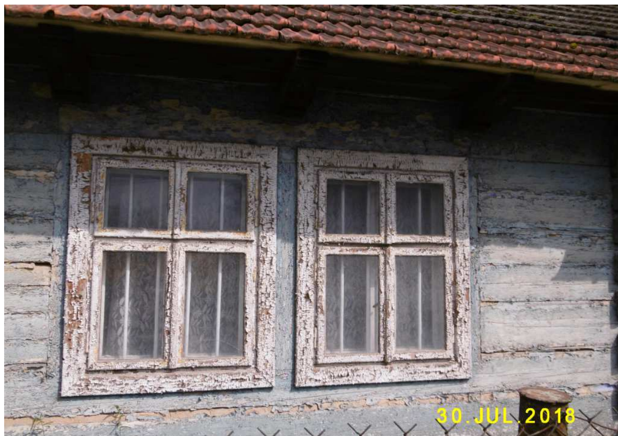
Fot. nr 23. Oryginalne okna.
