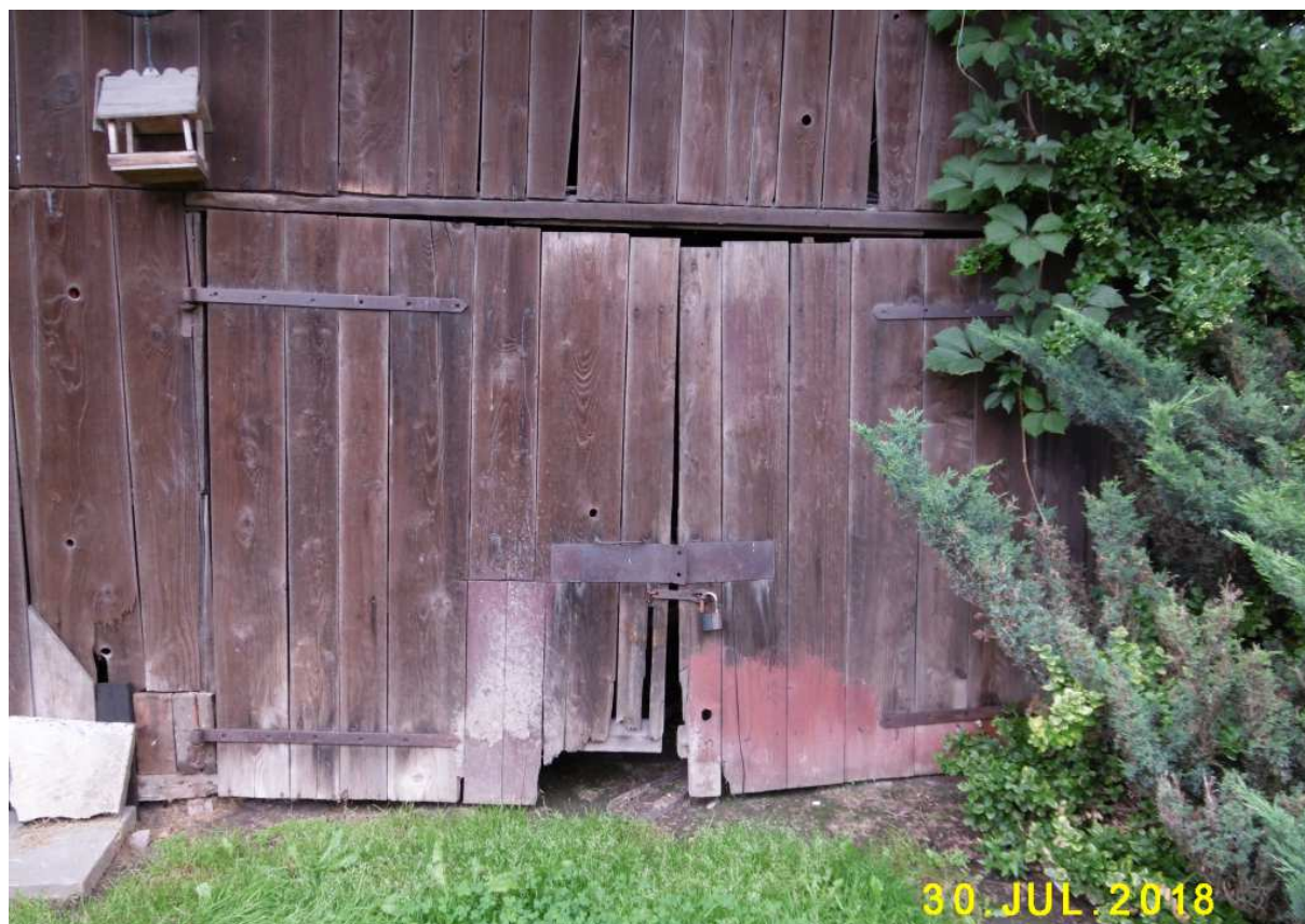
Fot. nr 15. Drzwi boczne do stodoły.
