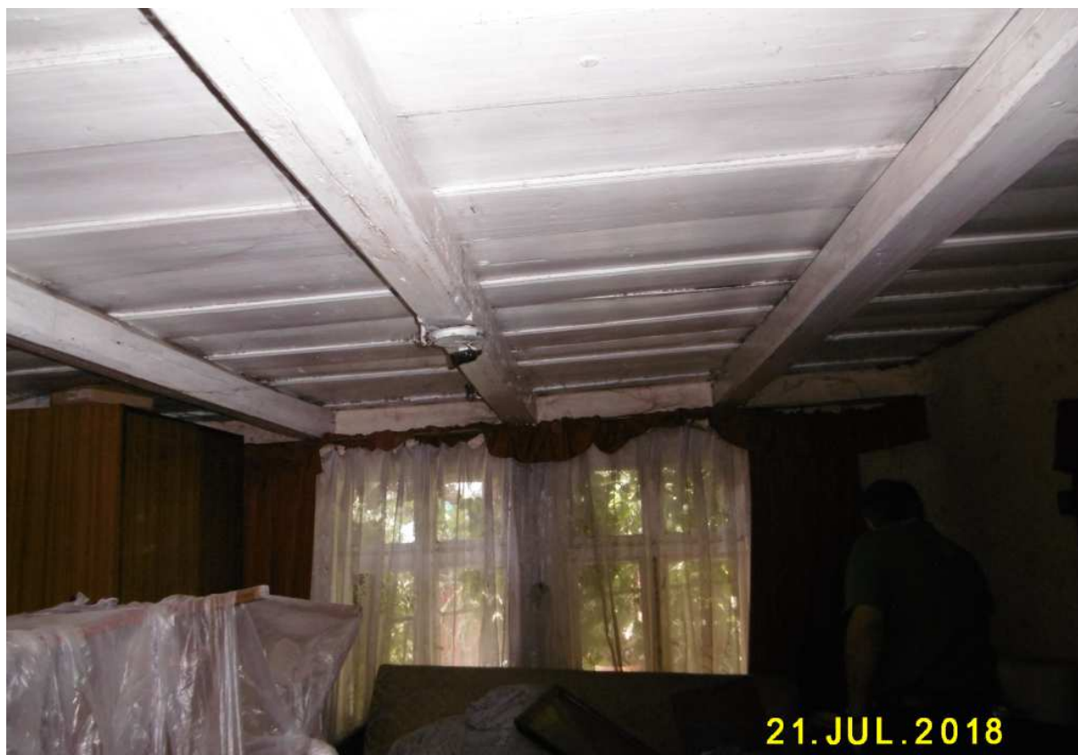
Fot. nr 104 (104-109). We wnętrzu chałupy. Pokój mieszkalny na kształt dawnej białej izby z belkami stragarzowymi.
