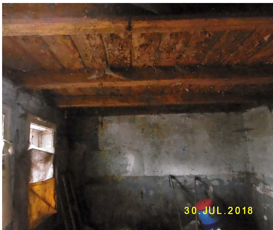
Fot. nr 49. Belki stragarzowe w izbie od strony ulicy.
