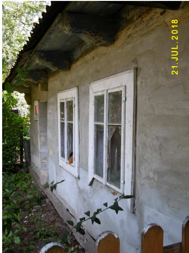
Fot. nr 56. Oryginalna okna lewej części, które wskazują na jej opuszczenie.
