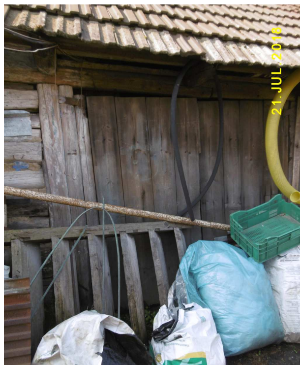
Fot. nr 111. Drzwi do części gospodarczej.
