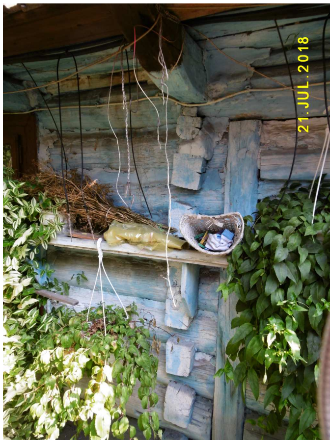
Fot. nr 98 (98-100). Fragmenty bielonych ścian o strukturze z poprzecznie układanych belek.
