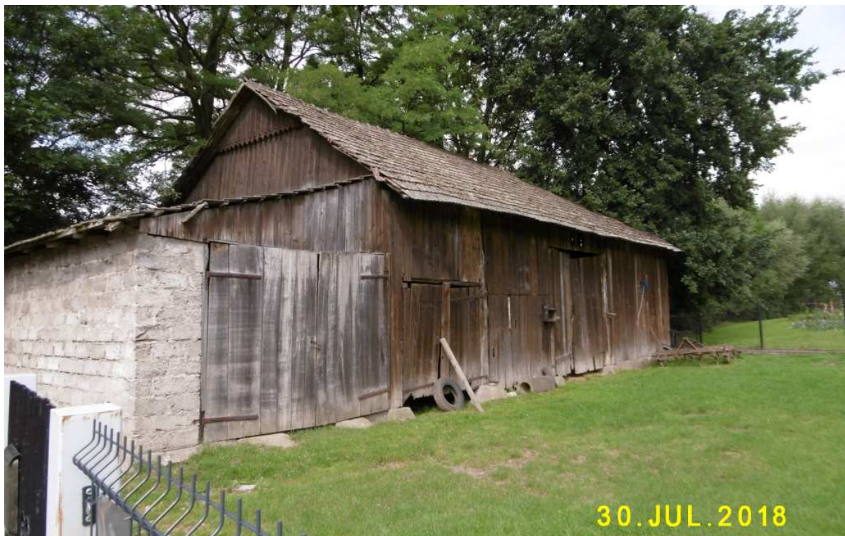
Fot. nr 38 (38-39). Przylegająca do domu stodoła, gdzie też mamy parę drzwi.
