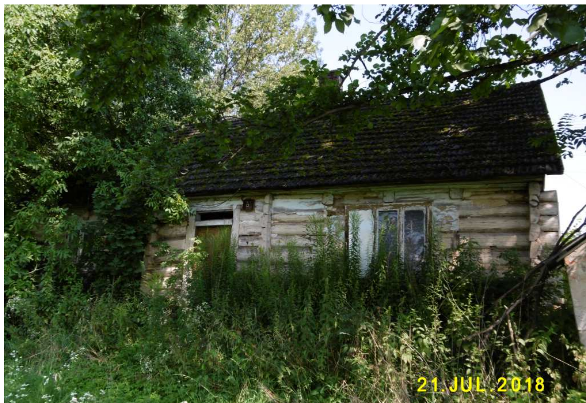
Fot. nr 81 (81-84). Widoki fragmentu chałupy od strony ogrodu.
