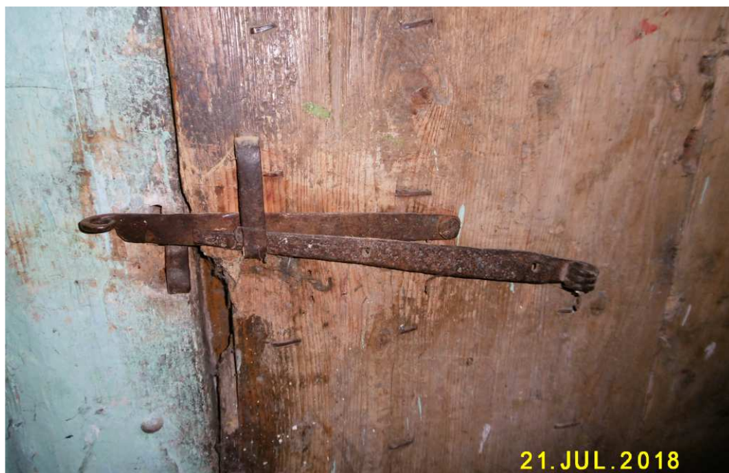
Fot. nr 85 (85-93). Detale z wnętrza chałupy. Tu metalowa zapadka do zamykania drzwi od wewnątrz.
