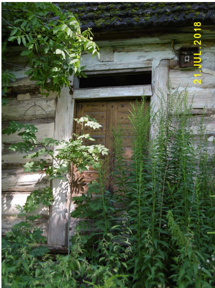
Fot. nr 83 (83-85). Drzwi i ich detale
