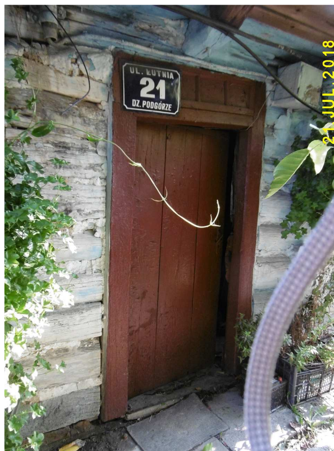
Fot. nr 97. Oryginalne drzwi z zamalowanym świetlikiem w ich zwieńczeniu.
