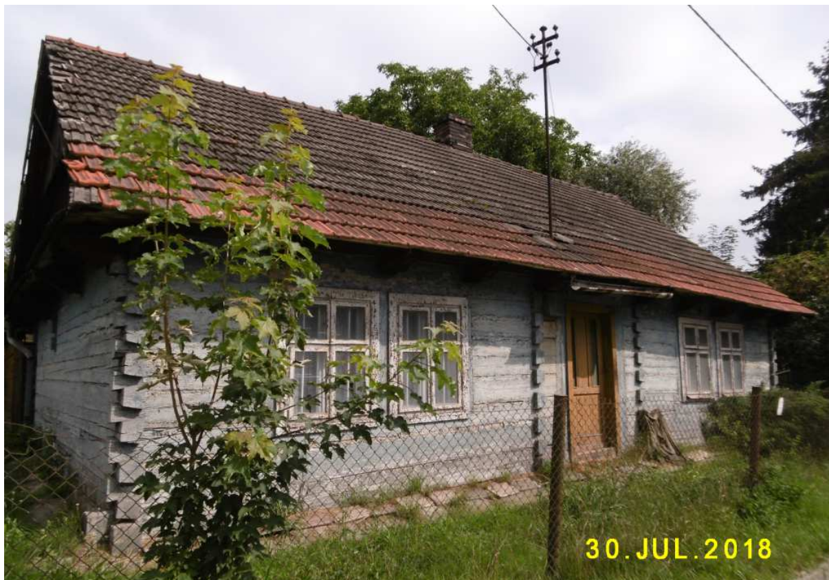
Fot. nr 21 (21-22). Fasada od strony ulicy
