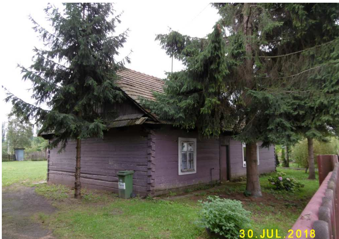
Fot. nr 35 (35-36). Chałupa z ulicy Lubockiej 16, też pochodząca z roku 1918.
