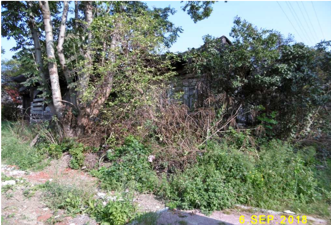
Fot. nr 3 (3-14). Chałupa z ulicy Skotnickiej 208. Tu jej zarośnięte przedpole.
