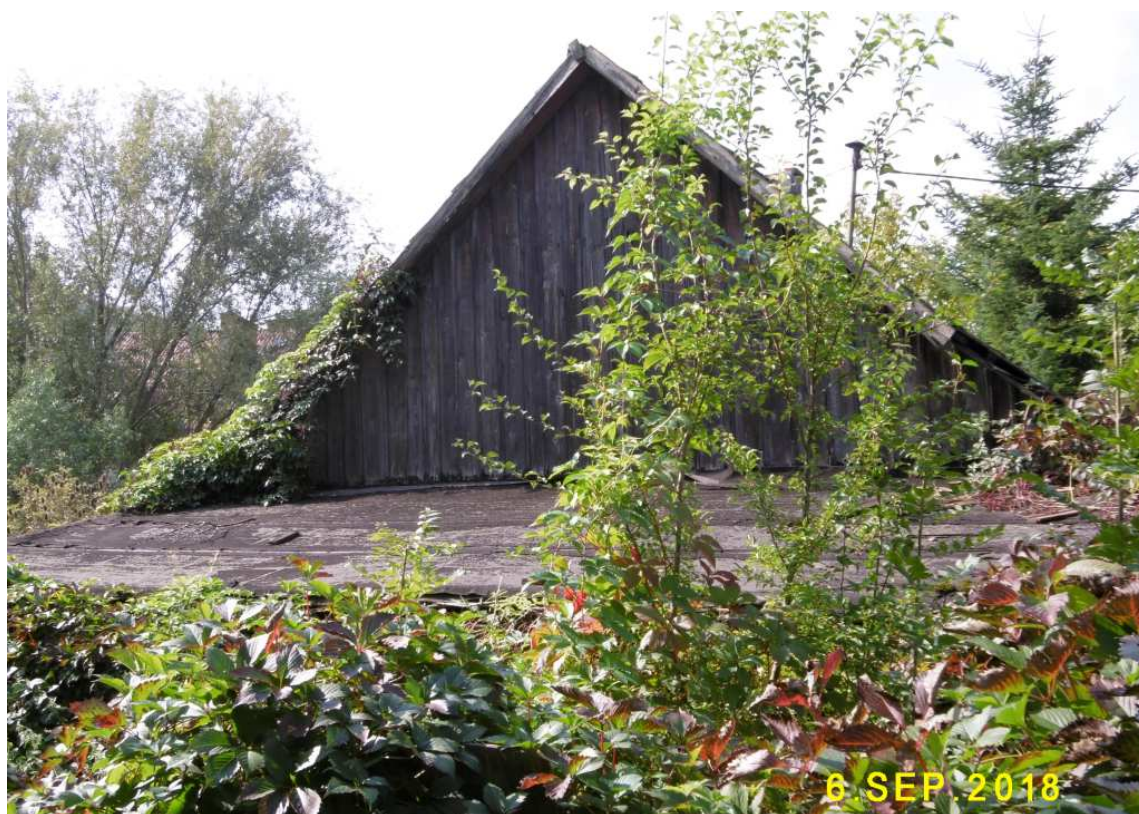
Fot. nr 54. Współczesny widok na boczną ścianę.
