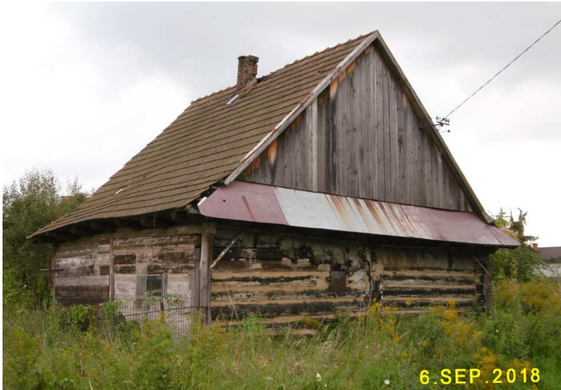
Fot. nr 87 (87-91). Chałupa z ulicy Budrysów 4, która mogła powstać na przełomie XIX i XX wieku. Jest w kiepskim stanie ogólnym. Tu część od strony dawnego podwórka.
