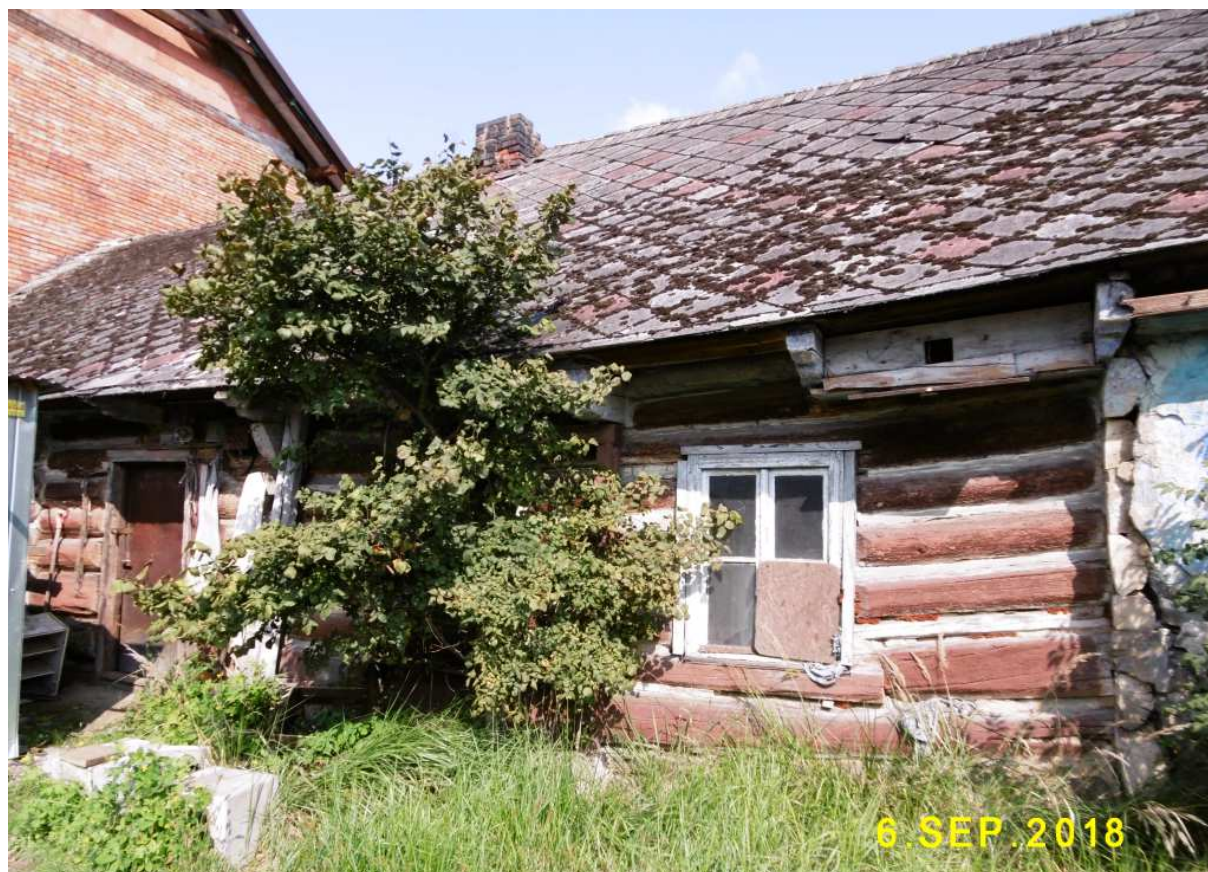
Fot. nr 57 (57-62). Kilka ujęć fasady
