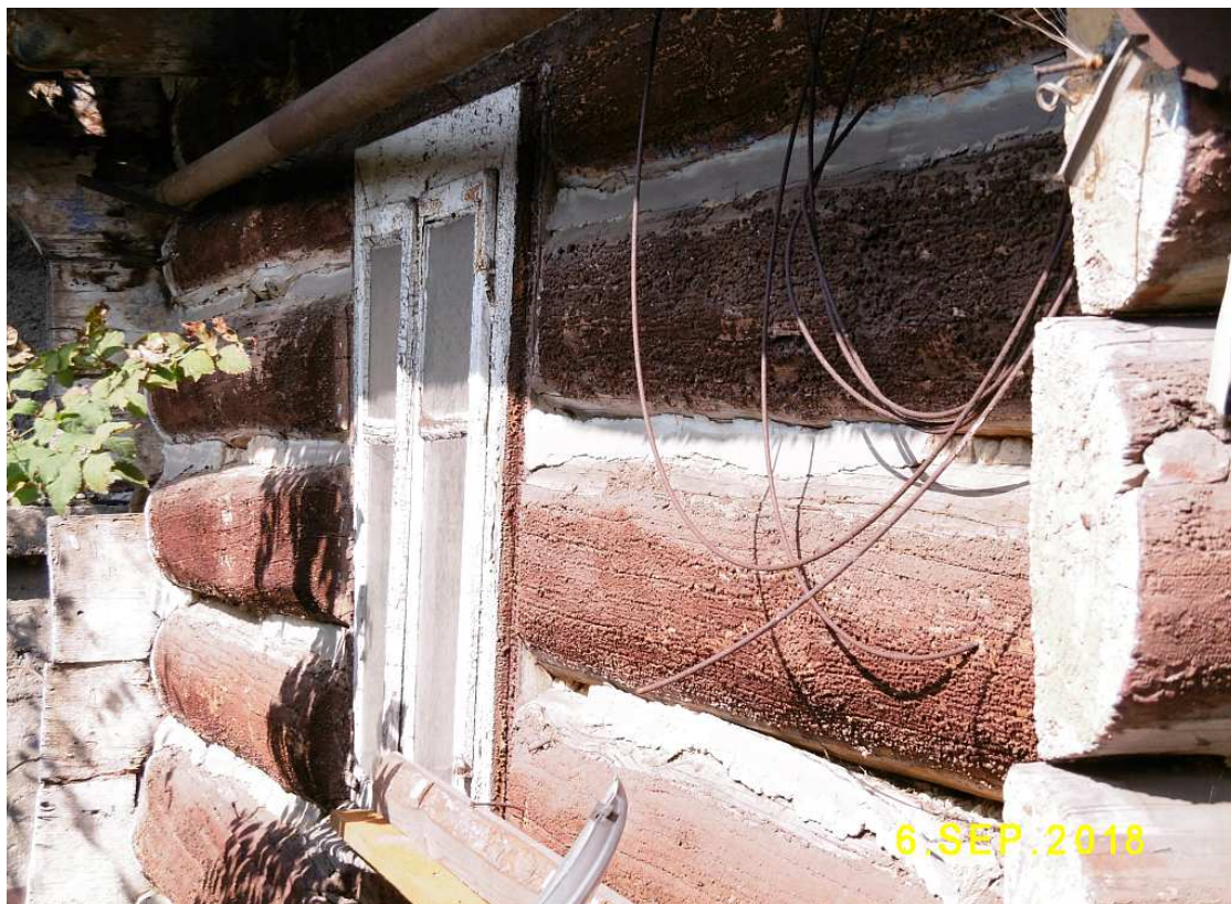
Fot. nr 61. Oryginalne okno.
