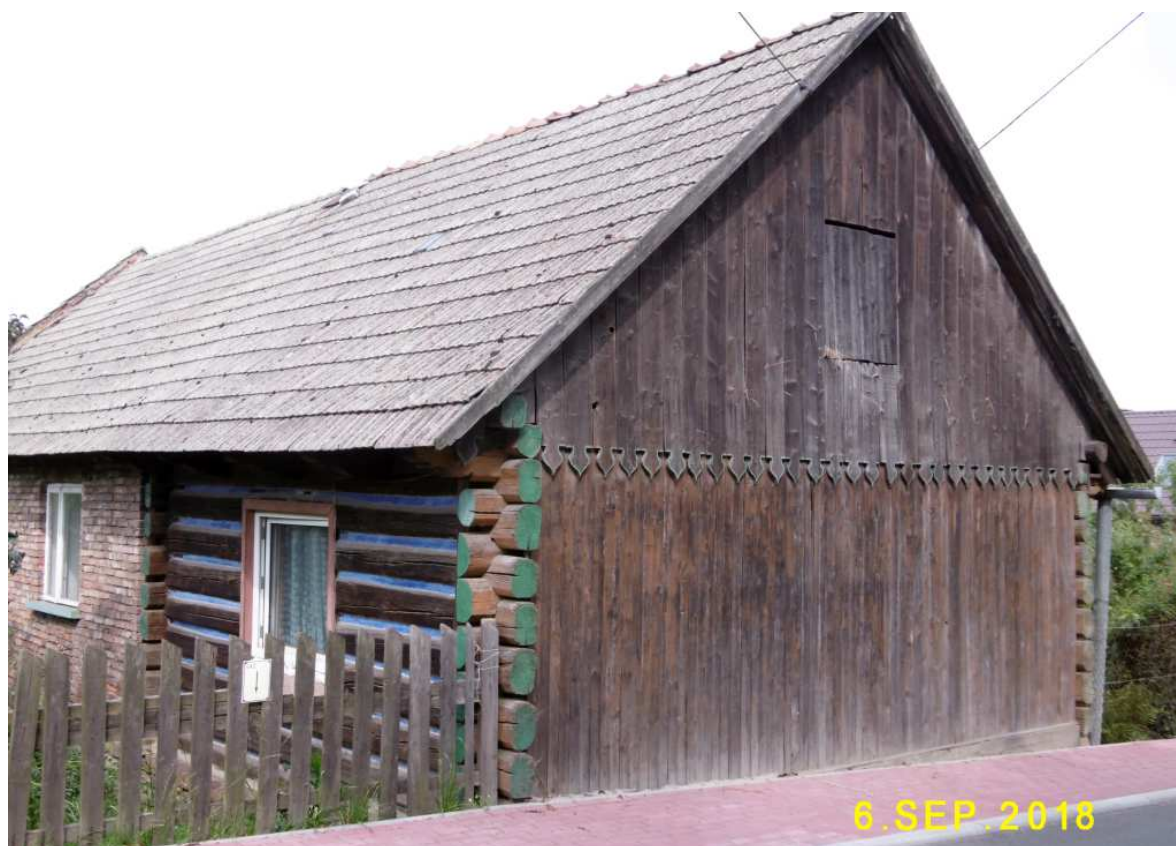
Fot. nr 25 (25-26). Widoki od strony ogrodu. Oryginalne okna drewniane zostały już zastąpione przez bezpodziałowe plastiki.
