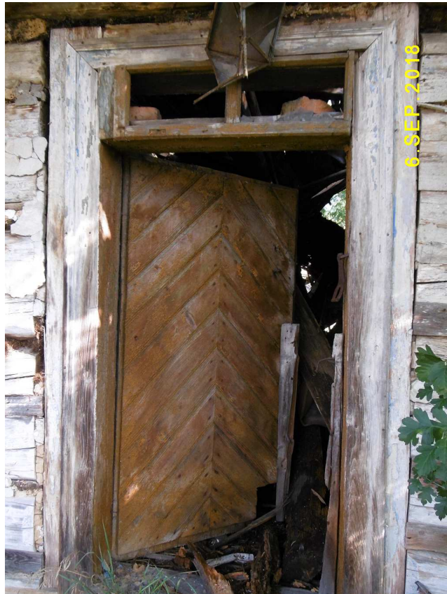
Fot. nr 7. Drzwi wejściowe ze świetlikiem nad nimi.
