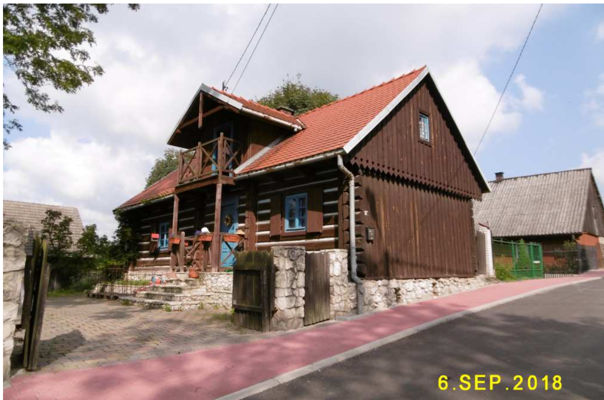
Fot. nr 15 (15-16). Przykładnie odrestaurowana chałupa spod nr 68.
