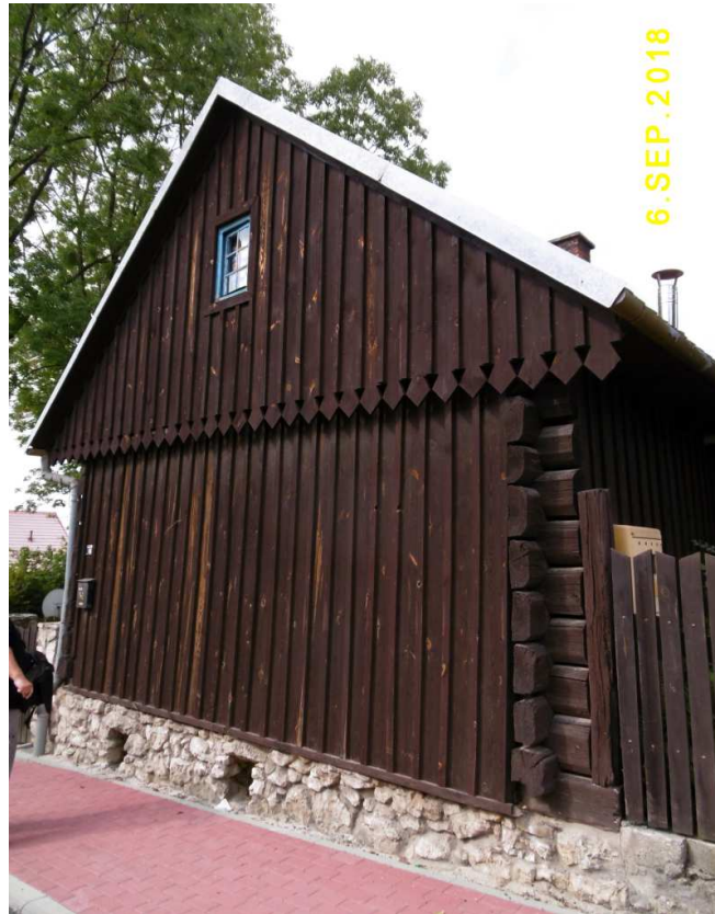
Fot. nr 17. Boczna ściana od strony ulicy.
