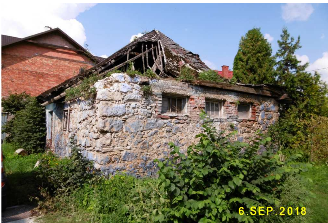
Fot. nr 56. Widok z ulicy na dawną stajnię.
