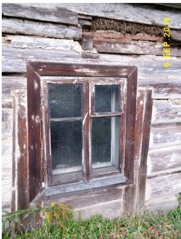
Fot. nr 90. Archaiczne okienko z lufcikiem.
