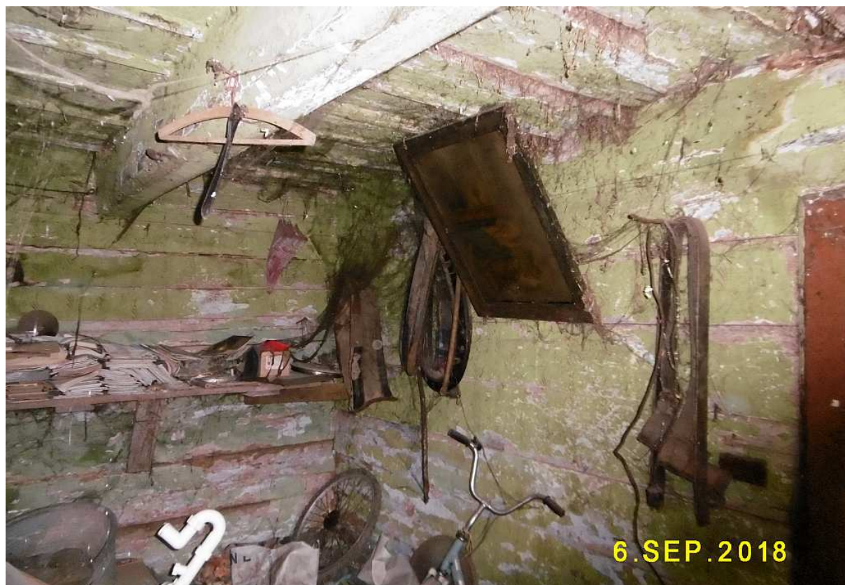
Fot. nr 77. Detale wnętrza.
