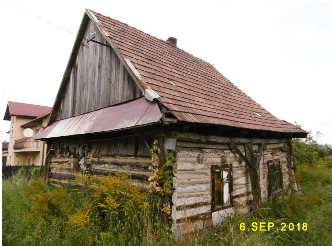
Fot. nr 88 (88-90). Fasada od strony dawnego ogrodu i jej zachowane detale.
