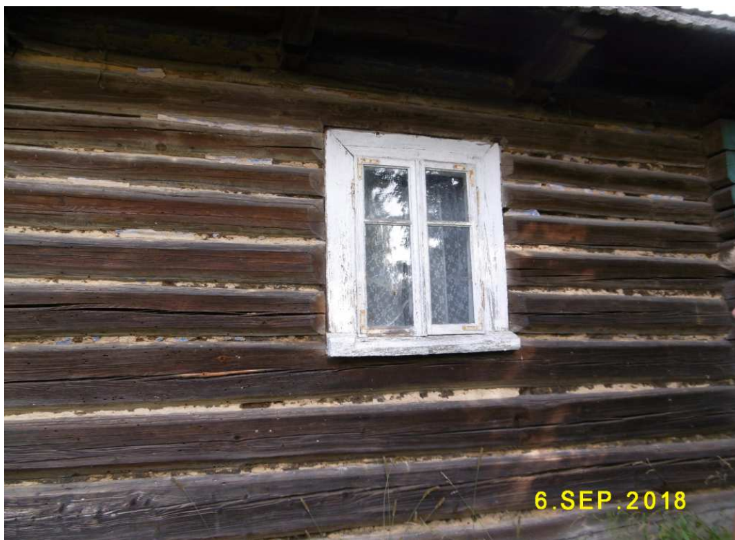
Fot. nr 43 (43-44). Oryginalne okno na malowanej kiedyś ścianie.
