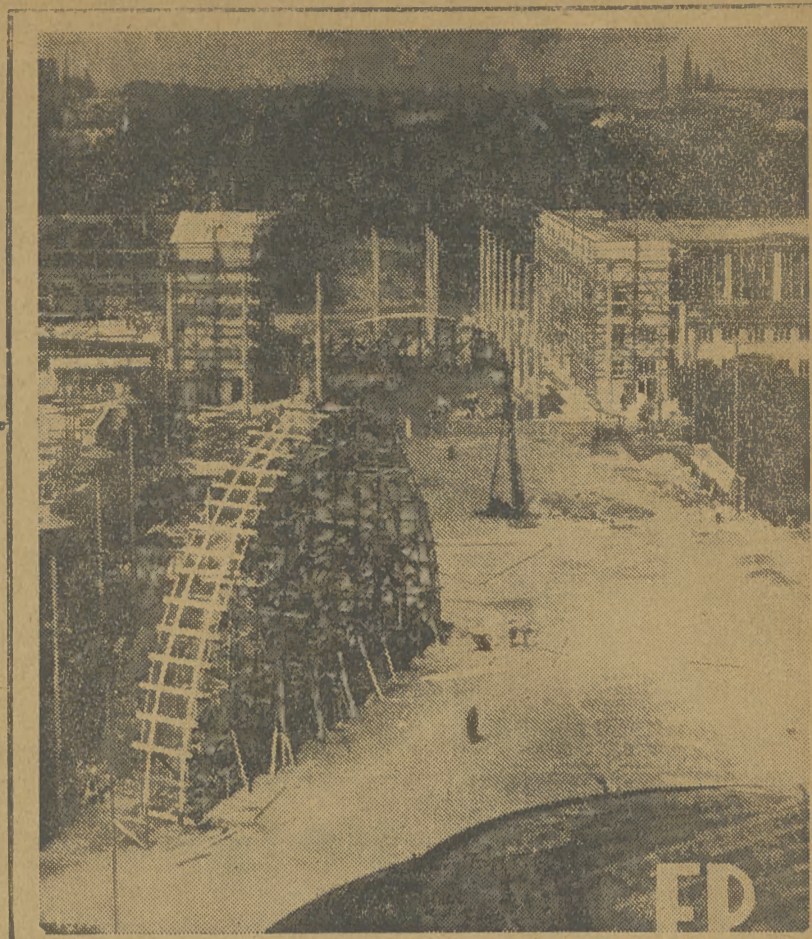
5. 6. 48 r. Przygotowania do Wystawy Ziem Odzyskanych. Główne wejście na pierwszym planie. Rusztowanie pod konstrukcję 103-metrowej iglicy.
