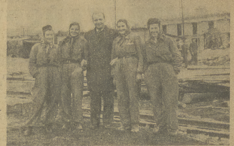
Kierownik Budowy Osiedla Mieszkaniowego w Jaworznie oraz „4 Marysie”, które przy miesiącu zaprawy wykonały 750 proc. normy: Brzezińska, Oc hań, Strzelec, Gólczyńska. (Fot. S. Senisson.)
