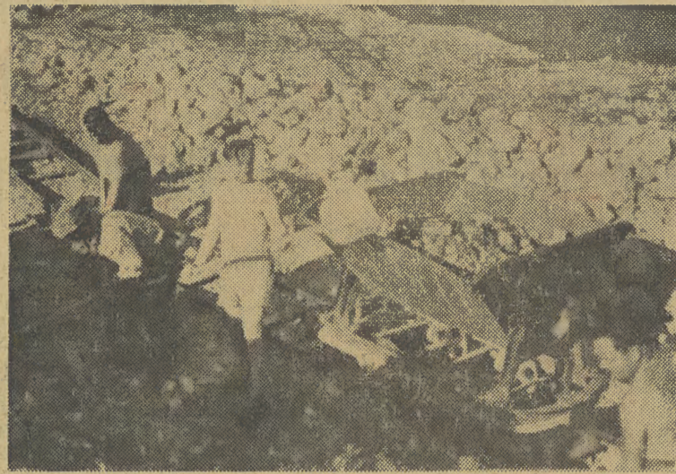
Sportowcy ZS „Włókniarz” pracują codziennie przy budowie własnego boiska.
