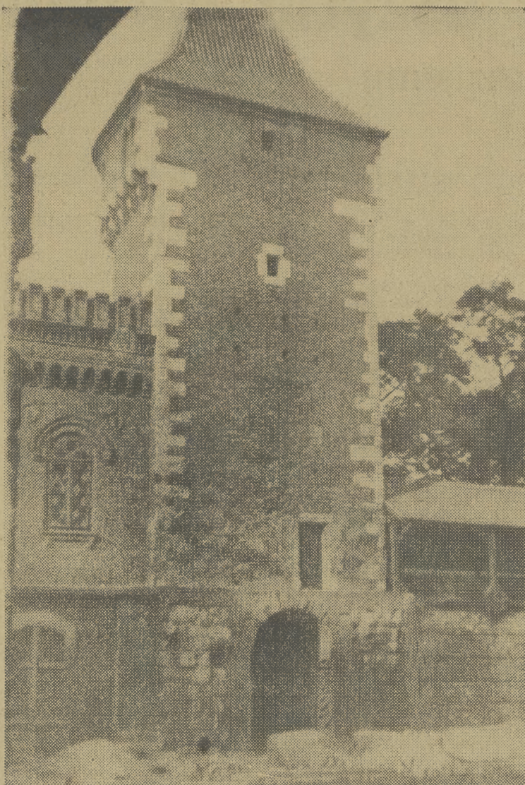
W roku bieżącym trwają prace budowlane nad rekonstrukcją wnętrza Baszty Sławkowskiej.
