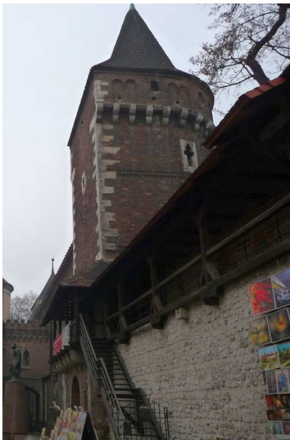
Fot. nr 31 (31-32). Baszta Stolarska. (09.03.2012)
