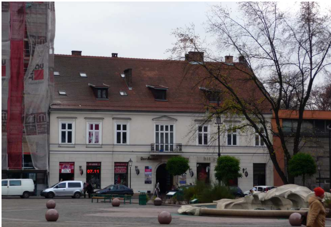
Fot. nr 187. Kamienica pod nr 3, której elewacja po remoncie zatraciła dawne klasycystyczne cechy. (10.11.2011)
