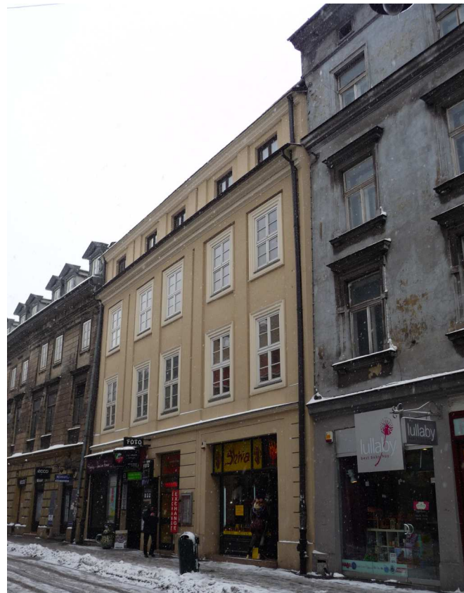
Fot. nr 210. Pałac Tarnowskich (z lewej) pod nr 15 i kamienica pod nr 13. (17.07.2012)
