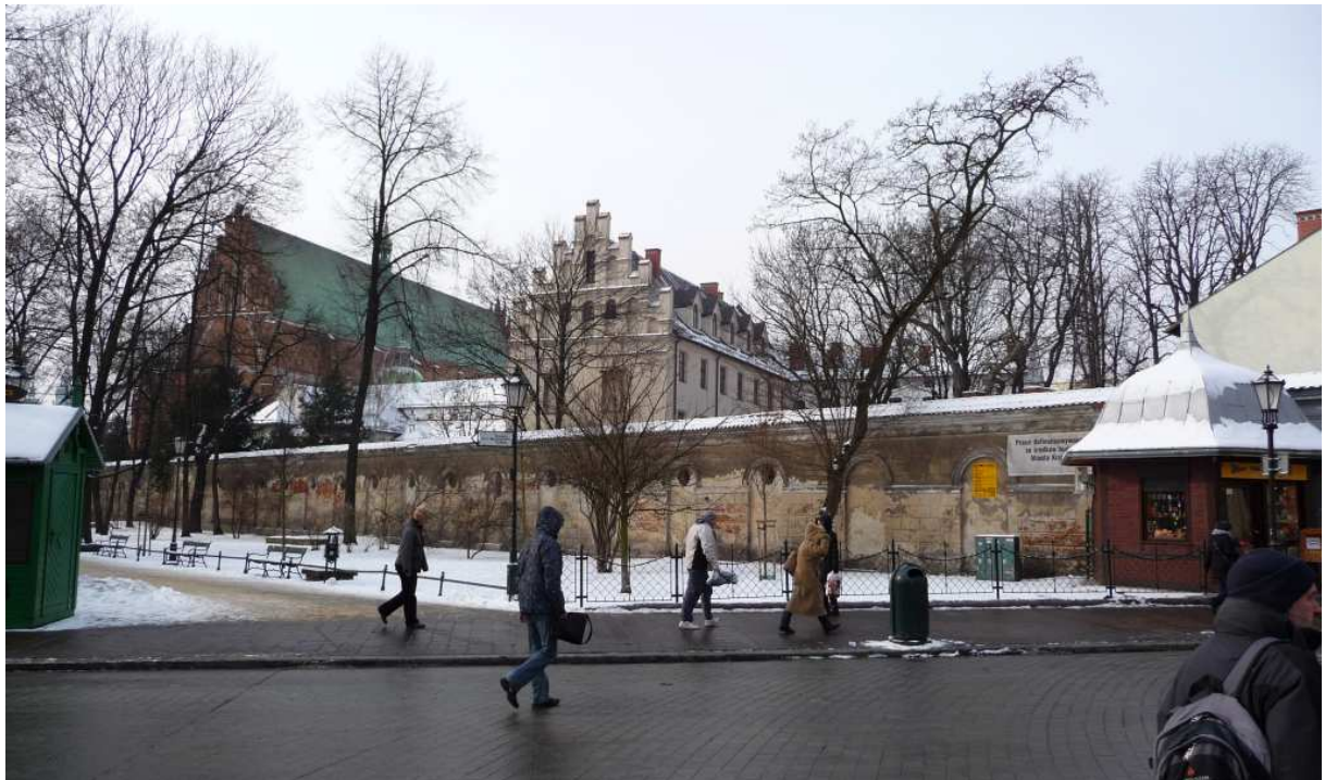
Fot. nr 336 (336-337). Zespół klasztorny Dominikanów od strony Plant. (08.02.2012)
