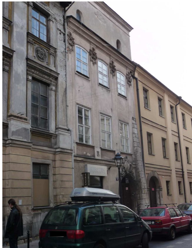
Fot. nr 240. Kamienica pod nr 9. (21.10.2011)
