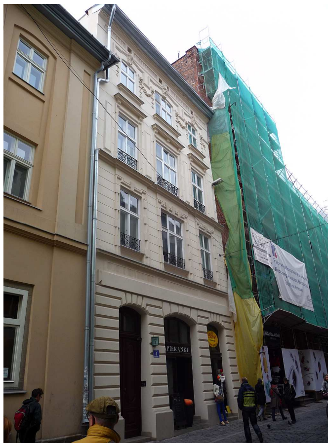
Fot. nr 350. Kamienica pod nr 3. (14.10.2011)
