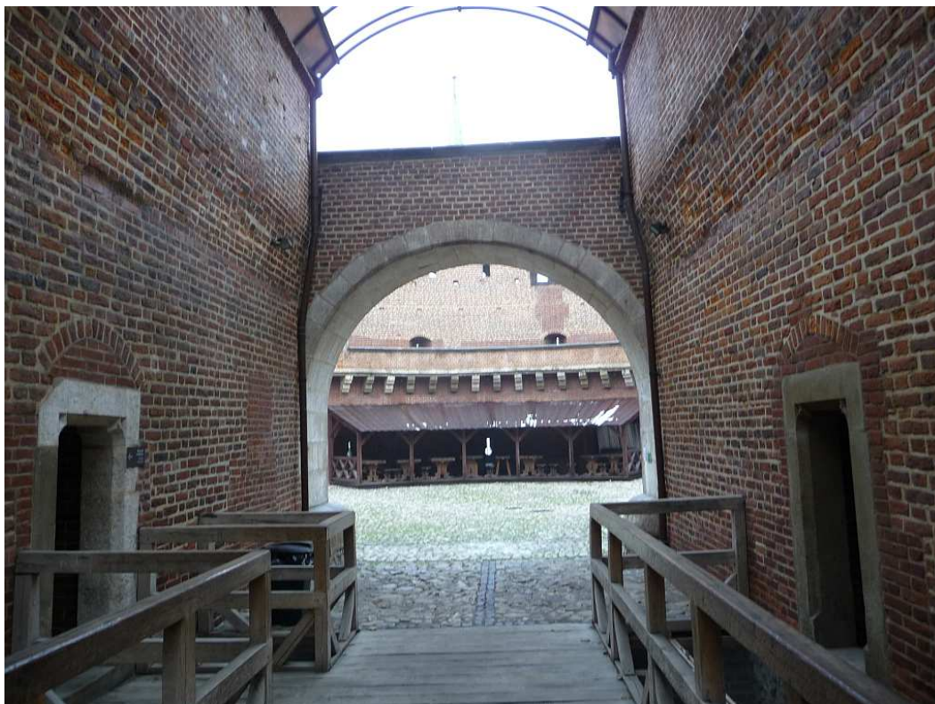
Fot. nr 19. Widok od strony dawnej szyi. (18.12.2012)
