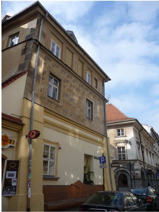
Fot. nr 231 (231-232). Budynek o boniowanej elewacji pod nr 35. (21.10.2011)
