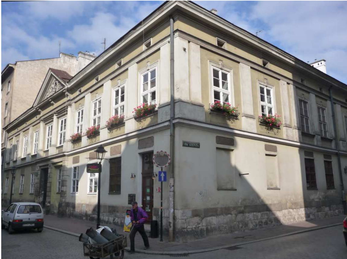
Fot. nr 230. Klasycystyczny budynek pod nr 28. (21.10.2011)
