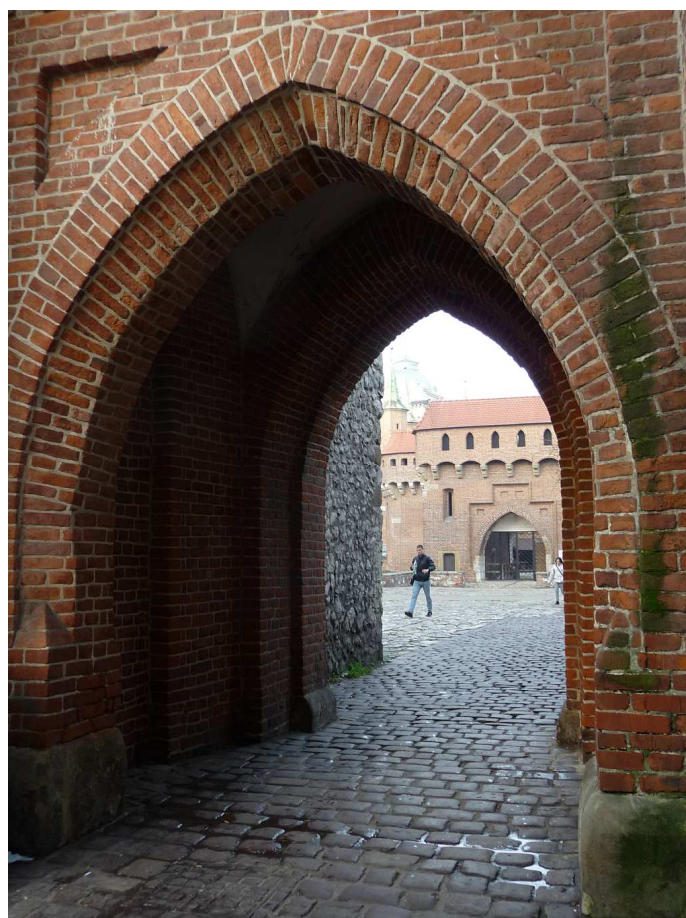
Fot. nr 20. Ujęcia z przejścia arkadowego pod Bramą Floriańską. (27.11.2012)
