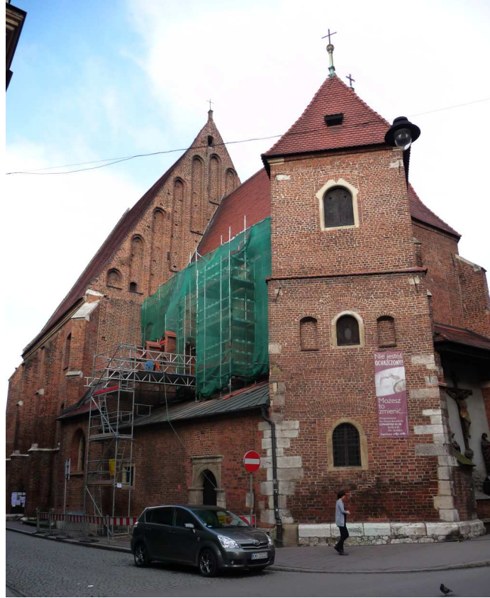
Fot. nr 213 (213-214). Kościół św. Marka. (21.10.2011)
