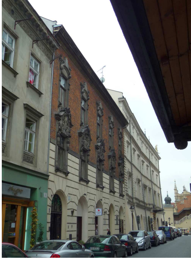
Fot. nr 235 (235-237). Kamienice pod nr 1 i 3 (Goetzów). (21.07.2012)
