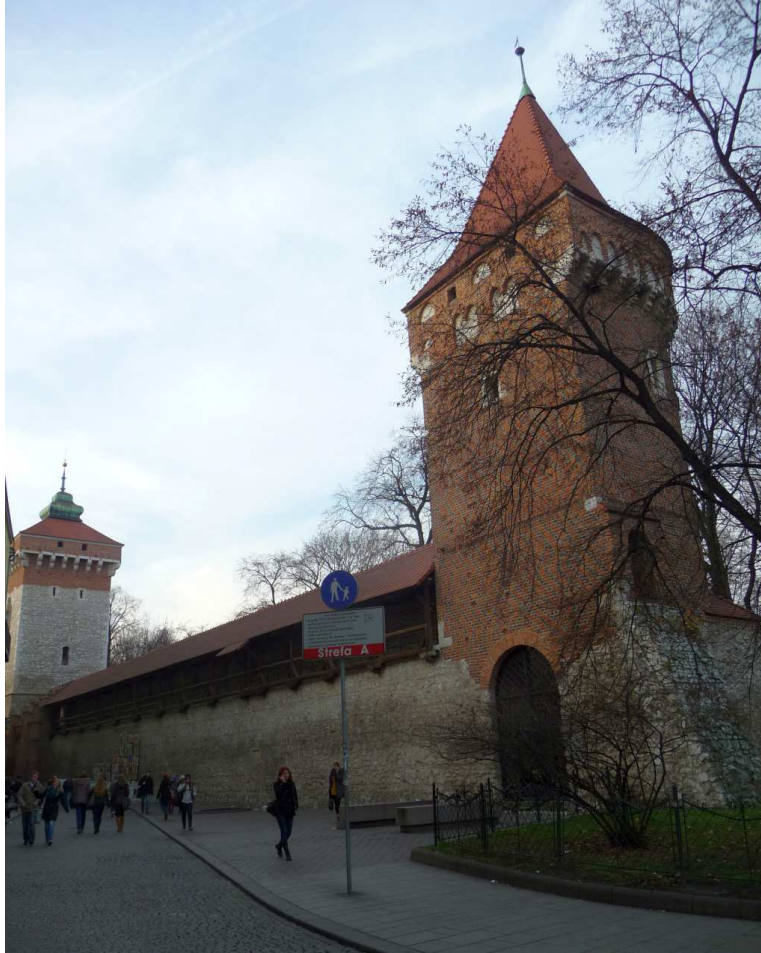
Fot. nr 29 (29-32). Mury obronne w ujęciach od strony ulicy Pijarskiej. (27.11.2012)
