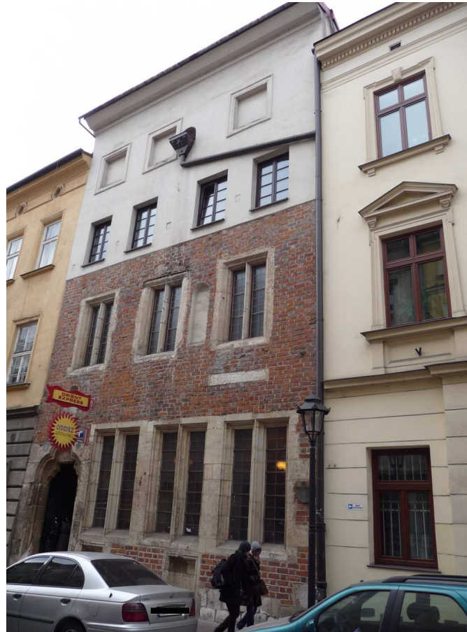
Fot. nr 289. Odtworzona fasada gotyckiego domu spod nr 8. (10.11.2011)
