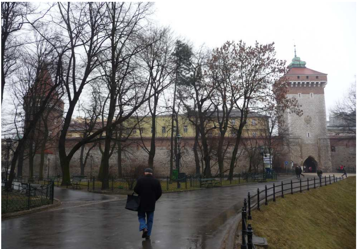
Fot. nr 22 (22-25). Kilka ujęć murów floriańskich od strony ulicy Basztowej. (09.03.2012)
