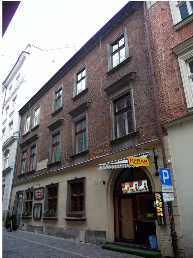
Fot. nr 353. Gotycka cegła w fasadzie kamienicy spod nr 4. (21.10.2011)
