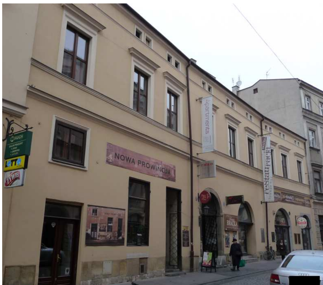
Fot. nr 158. Budynek pod nr 3. (23.11.2011)
