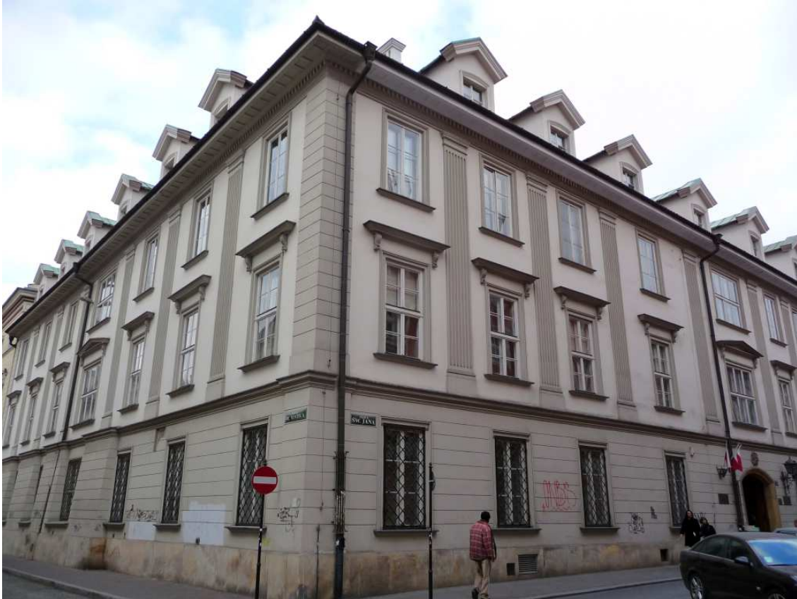
Fot. nr 245. Klasycystyczna kamienica (nr 22) w narożu z ulicą św. Marka. (10.11.2011)
