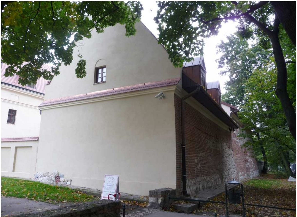
Fot. nr 150. Budynki klasztorne na linii Plant. (14.10.2011)
