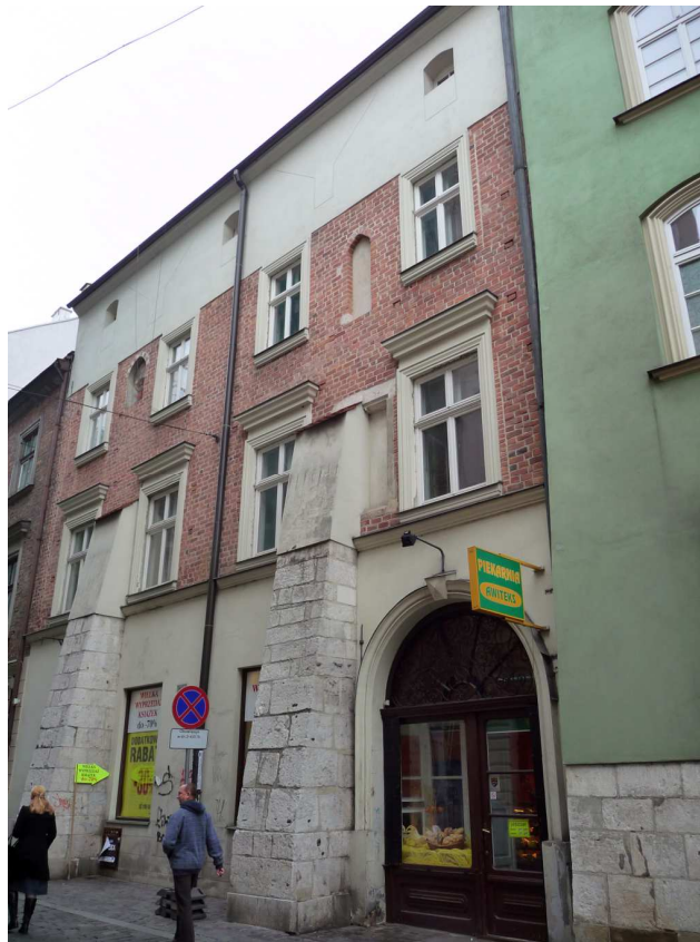
Fot. nr 352 (352-353). Kamienica spod nr 6. (21.10.2011)
