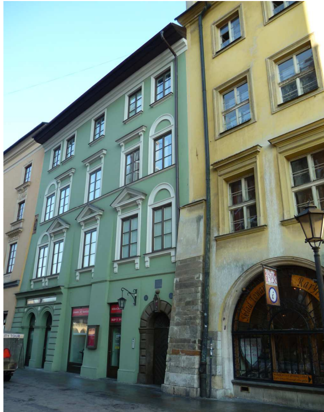
Fot. nr 381. Kamienica pod nr 2. (06.12.2012)
