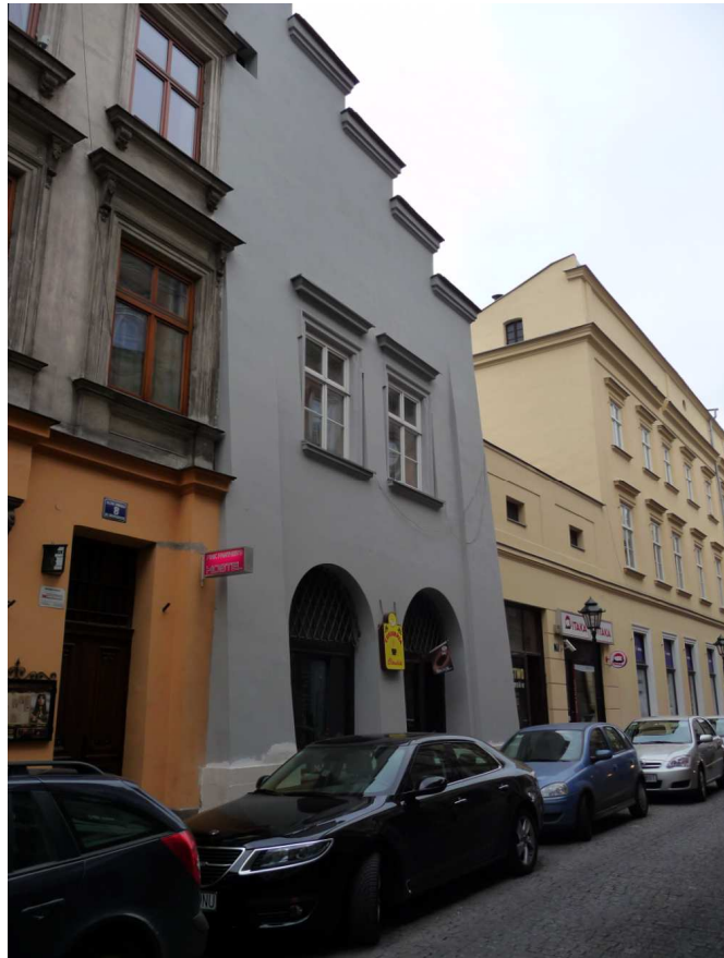
Fot. nr 221. Dom pod nr 10 i jego schodkowy dach. (10.11.2011)
