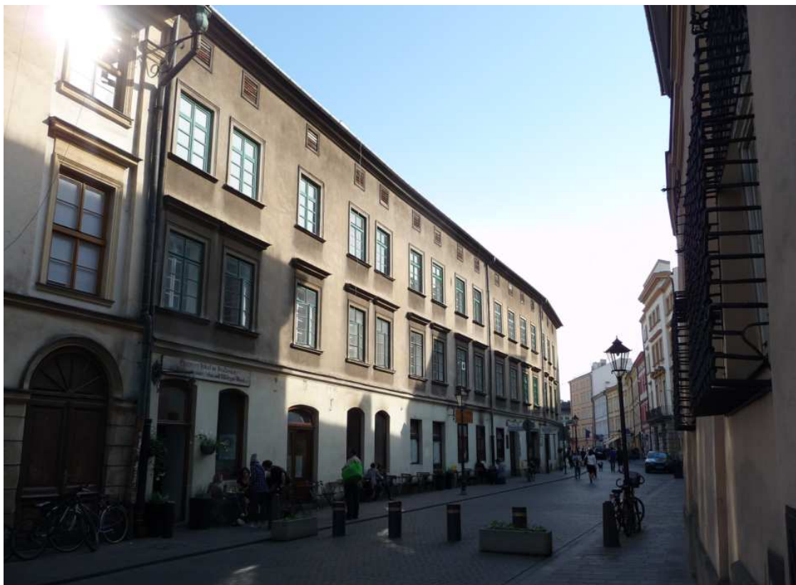
Fot. nr 390. Kamienica pod nr 4, gdzie na I piętrze jeszcze zachowały się oryginalne okna. (28.05.2012)
