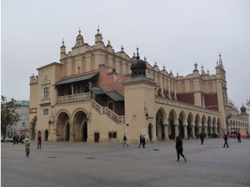
Fot. nr 127. Południowo-wschodni narożnik Sukiennic. (21.10.2011)
