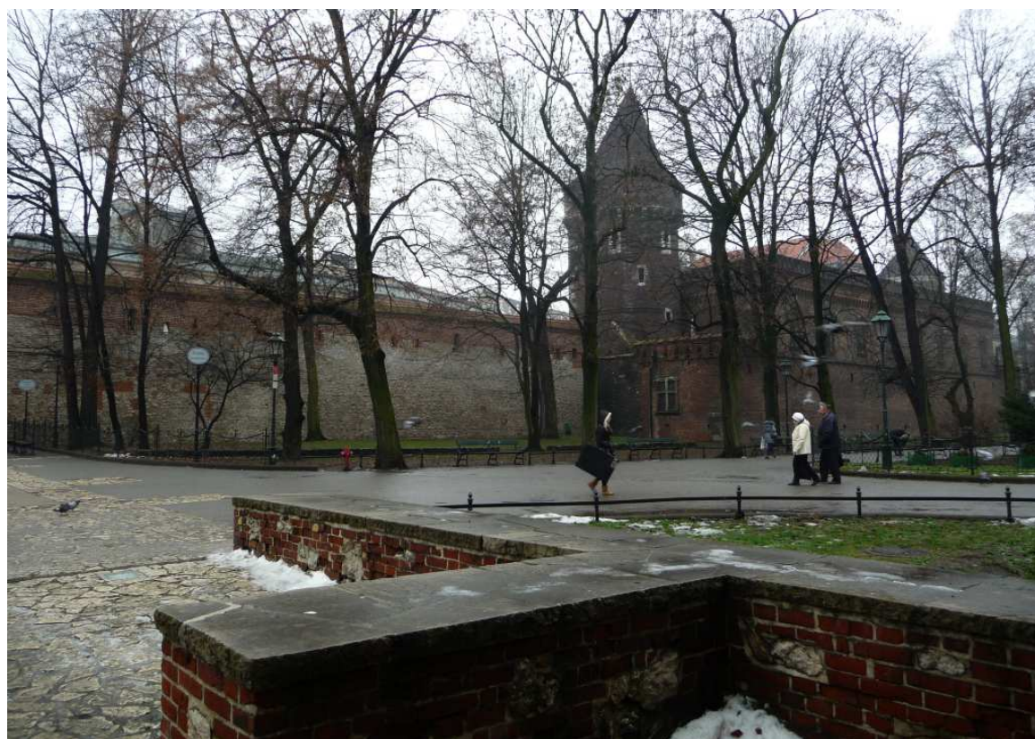
Fot. nr 26. Baszta Stolarska. (18.12.2012)
