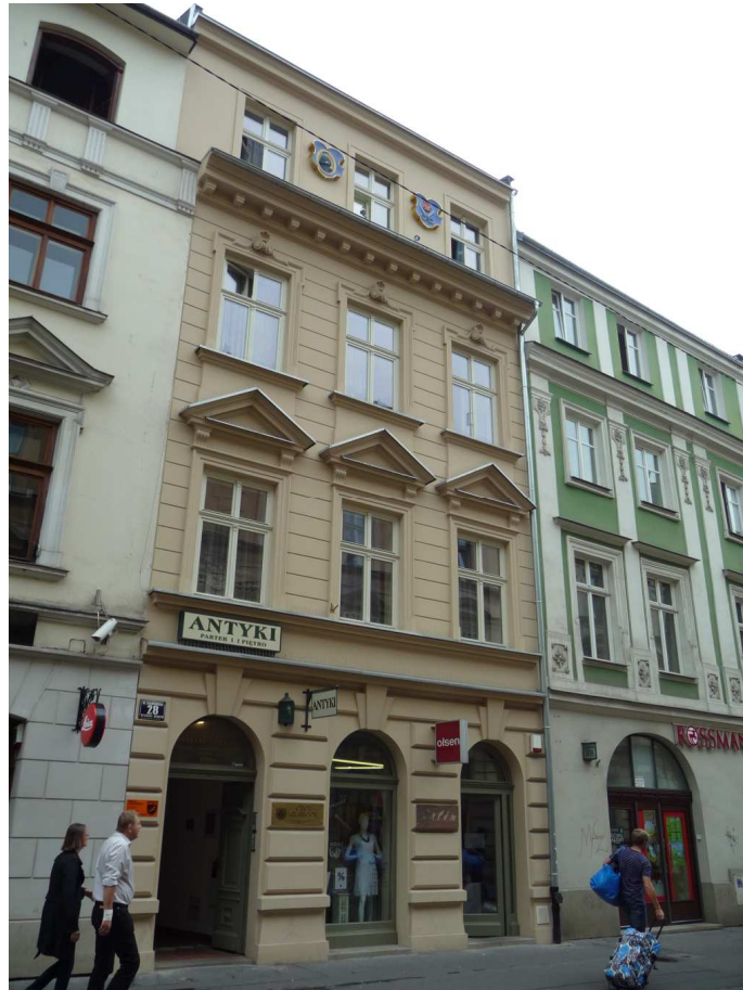
Fot. nr 217. Kamienica pod nr 28. (21.07.2012)
