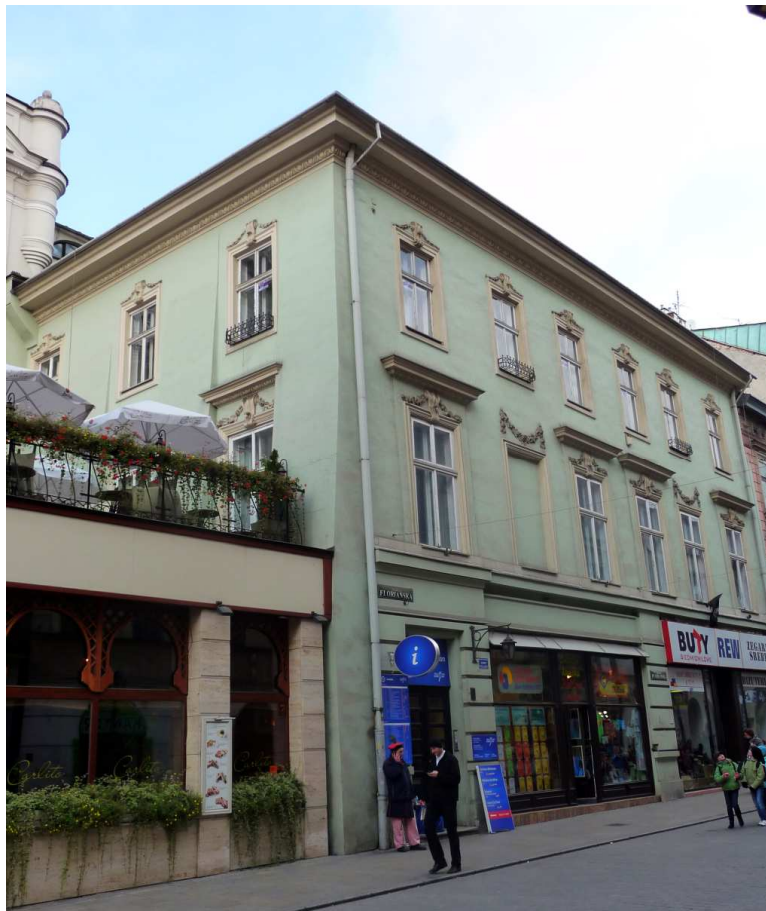
Fot. nr 50. Kamienica pod nr 28. (21.10.2011)
