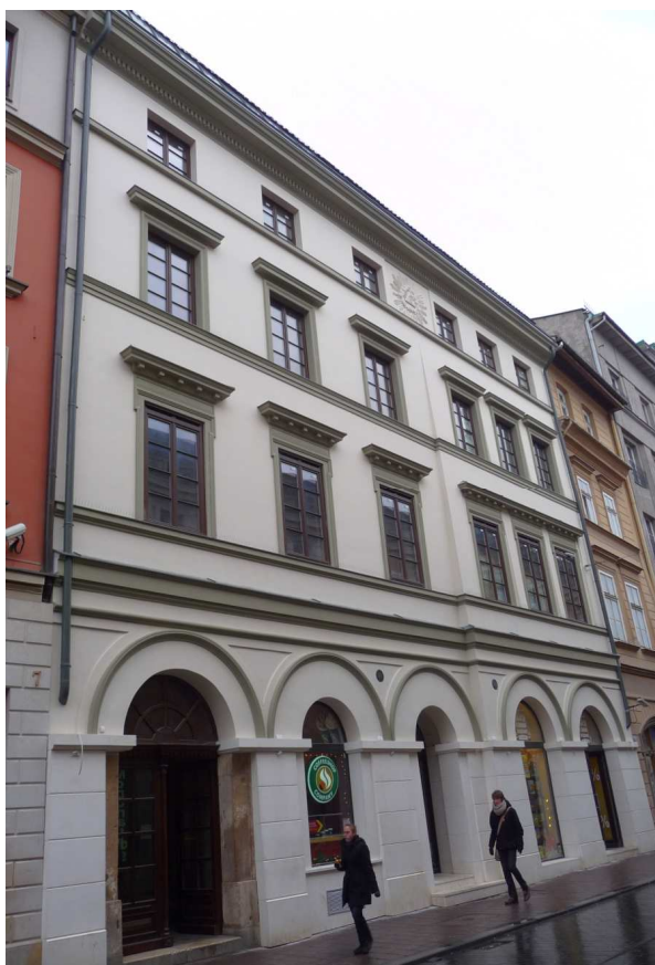
Fot. nr 176 (176-177). Odnowiona fasada kamienicy pod nr 7. (10.01.2012)
