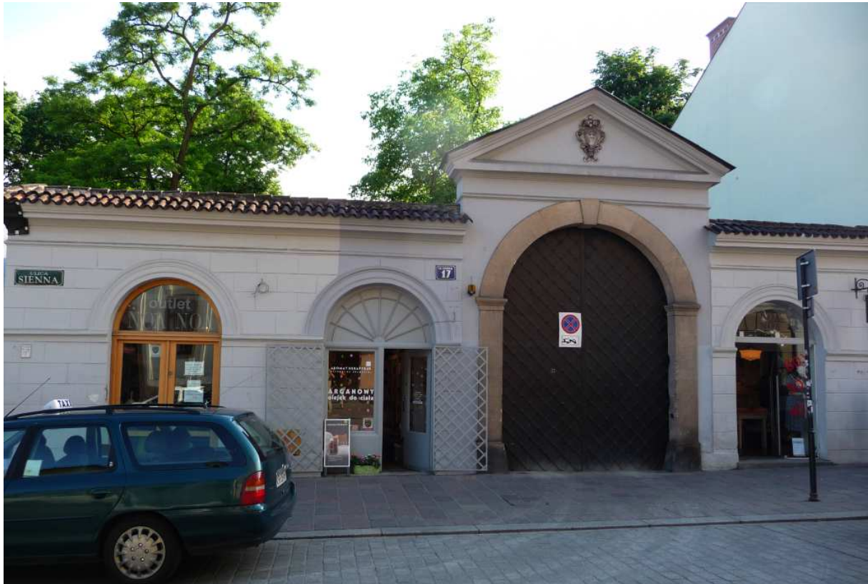
Fot. nr 343. Brama wjazdowa na teren dawnych jatek poddominikańskich pod nr 17. (28.05.2012)
