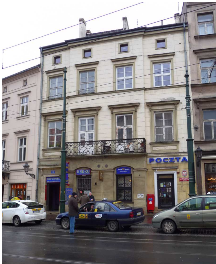
Fot. nr 152. Klasycystyczna kamienica z ulicy placu Wszystkich Świętych 9. (10.01.2012)
