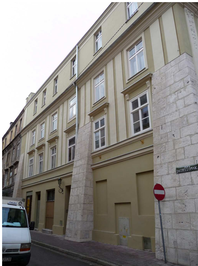
Fot. nr 171. Porażająca pstrokacizną okien kamienica pod nr 7. (07.01.2012)
