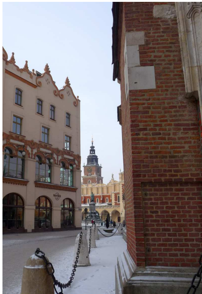
Fot. nr 388. Dawna kamienica Czynciela w narożu Rynkiem Głównym 4. (08.02.2012)
