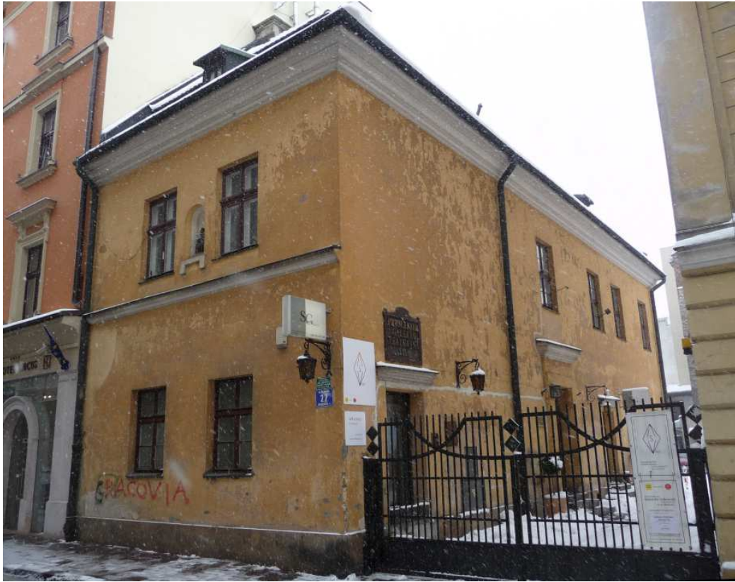
Fot. nr 261. Odbudowany na nowo dom pod nr 22. (27.02.2012)
