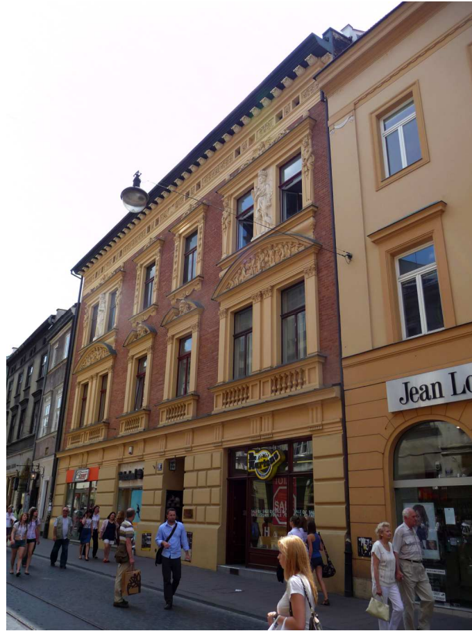
Fot. nr 181. Kamienica pod nr 20. (29.06.2012)
