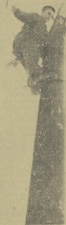
Po drodze zatrzymano się fesszcz, aby wzmożnić rozluźnione izolatory na jednym ze stópów. Monter Pogotowia Elektrycznego daje właśnie znak: gotów!
