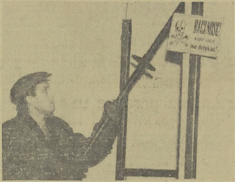
Kazimierz Majewski wziął gumowe rękawice i specjalnymi szczytkami (również „antyprądowymi” — chroniącymi przed porażeniem) bada urządzenia podstacji.
