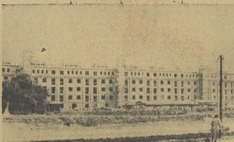
Budowa nowych domów mieszkalnych w Krakowie.
