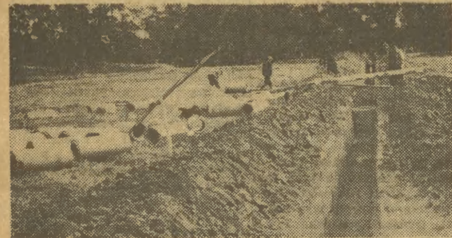
Prace przy drenażu boiska prowadzą robotnicy ZRI. Na zdjęciu układanie przewodów. Fot. J. Rumianowski
