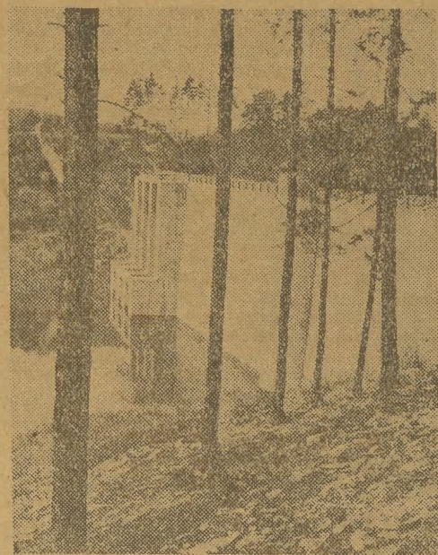
Widok głównej części zapory wodnej na rzece Weida w okręgu Gera. Całkowita pojemność zbiornika wynosi 10 mln metrów sześciennych.
