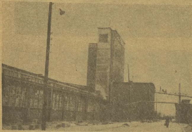
Centralna betoniarnia to „serce” zakładu. Tu dokonuje się najistotniejsza produkcyjna praca.
