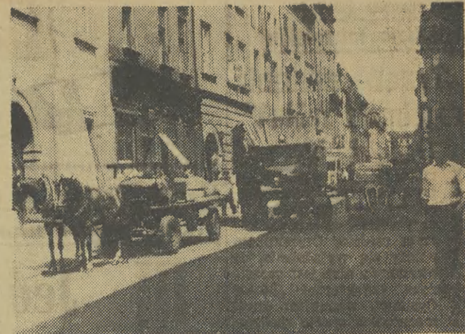
Ulica Szpitalna jest chyba najbardziej przeciążona ruchem ze wszystkich arterii środkowego. Wiedza o tym dobrze kierownicy z trudem przepychający swe pojazdy między platformami, wozami i samochodami ciężarowymi. Istnieją dwa wyjścia z kłopotliwej sytuacji: albo uruchomić ulicę jednokierunkową, albo uruchomić skład Woj. Przedsiębiorstwa Handlu Meblami, którego klienci blokują przejazd. Fot. J. Lewicki
