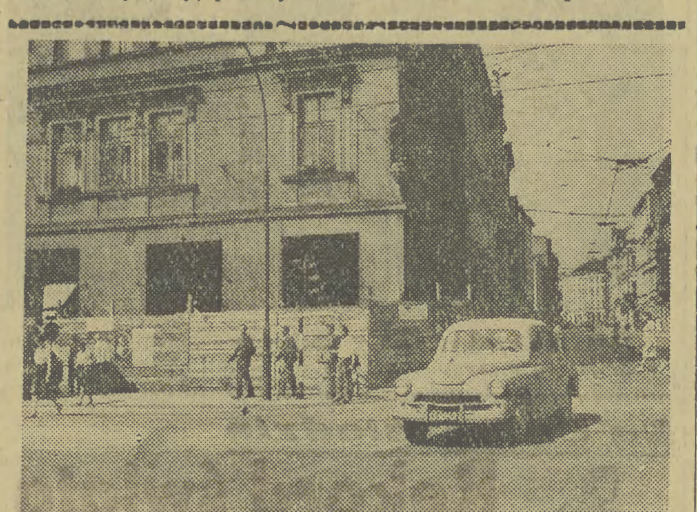
Prace przy budowie arkad przy rogu ul. Długiej i Basztowej wkrótce dobiegną końca. Na chwilę tę niecierpliwie czeka już MPK, by natchyniał włączyć do komunikacji nową linię tramwajową, która połączy wygodnie Kleparz ze Zwierzyńcem. Fot. W. Pawłowski
